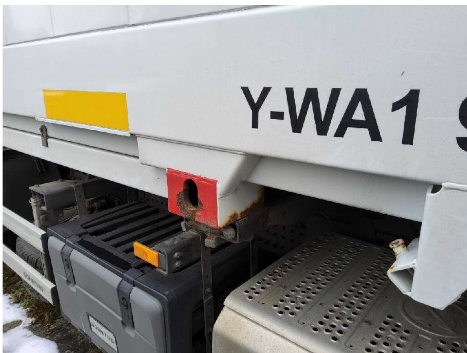
Bild 16 Aufbau Containerverriegelung korrodiert
