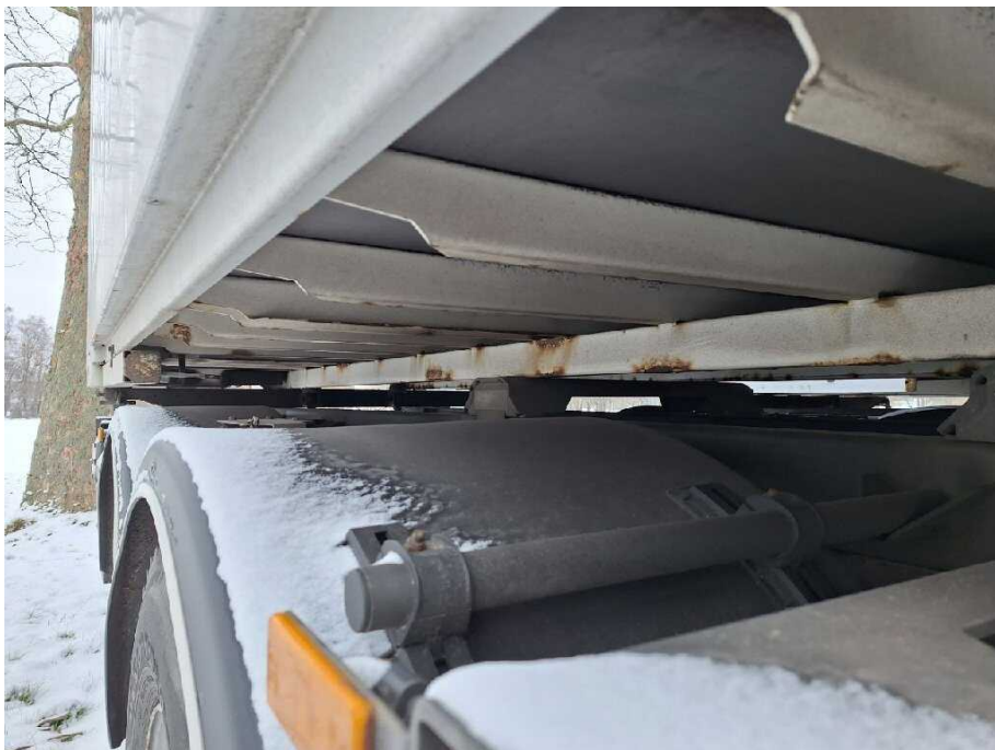
Bild 11 Fahrzeugheck Rahmen hinten korrodiert
