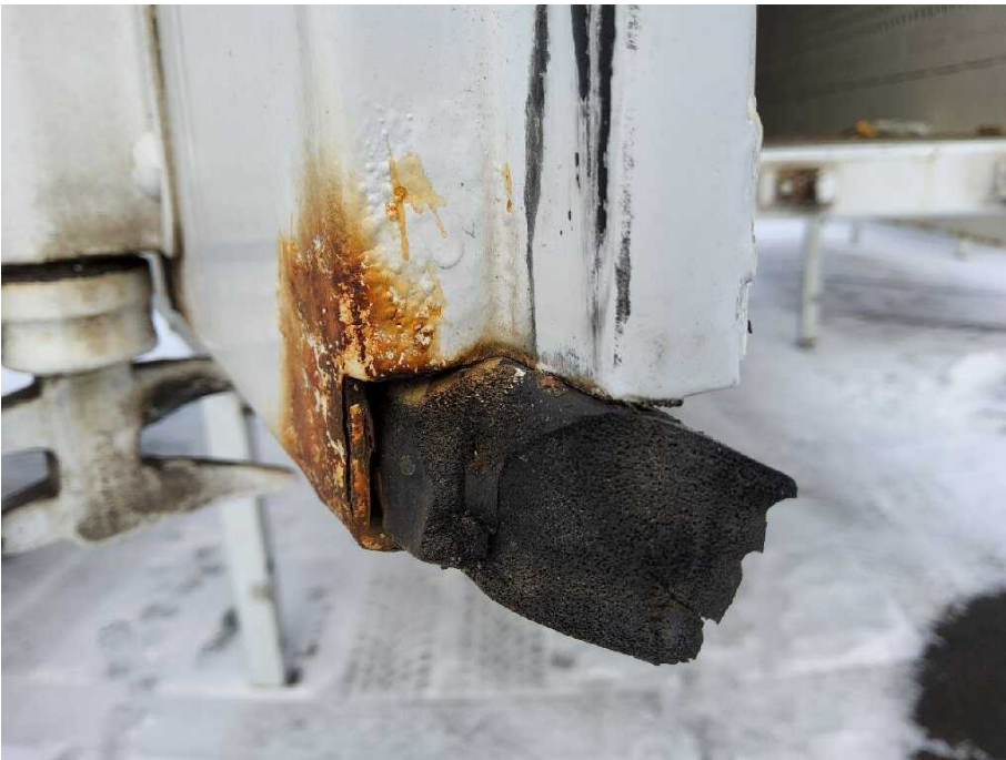
Bild 20 linke Seite Tür hinten links korrodiert
