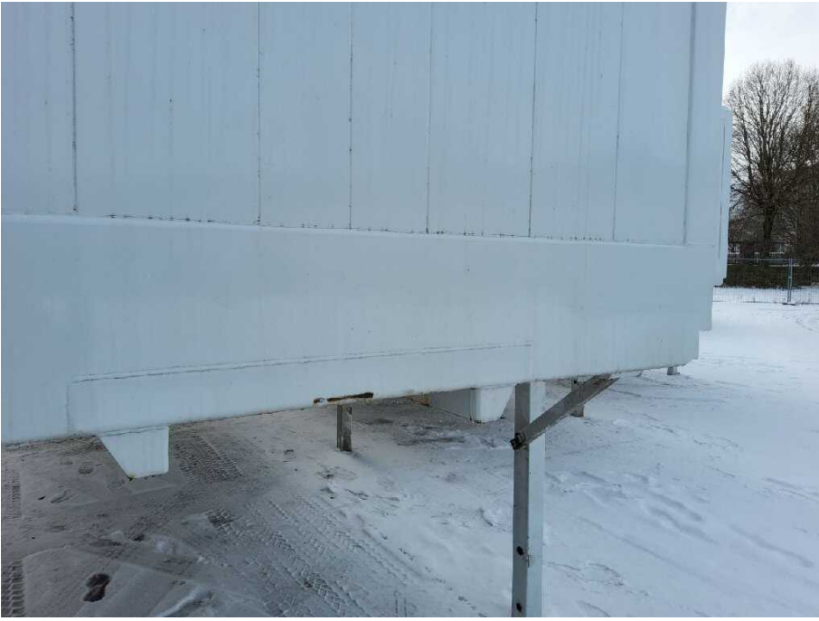
Bild 9 Fahrzeug sonstige Karosserieteile korrodiert
