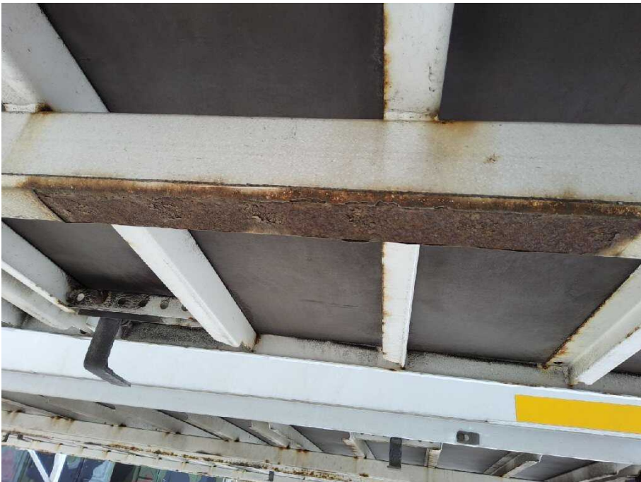
Bild 14 Aufbau Bodenrahmen hinten korrodiert
