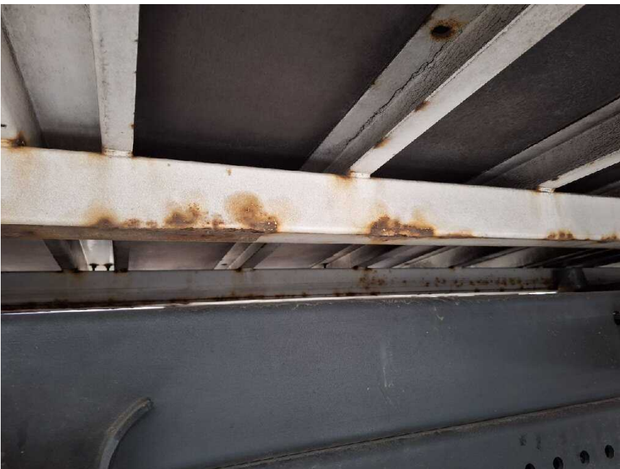
Bild 16 Aufbau Bodenrahmen hinten korrodiert
