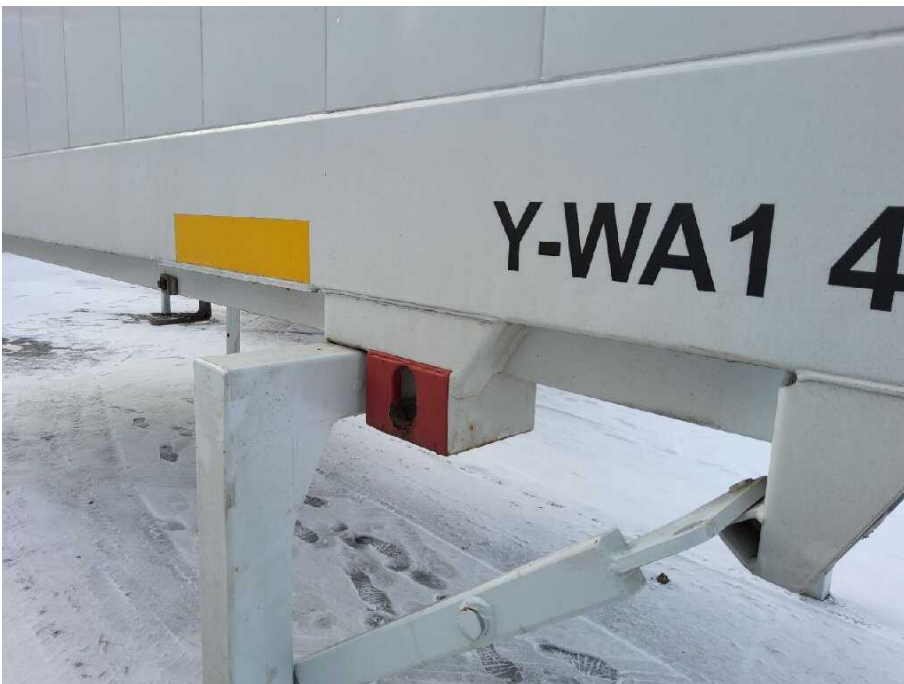
Bild 22 Aufbau Containerverriegelung korrodiert
