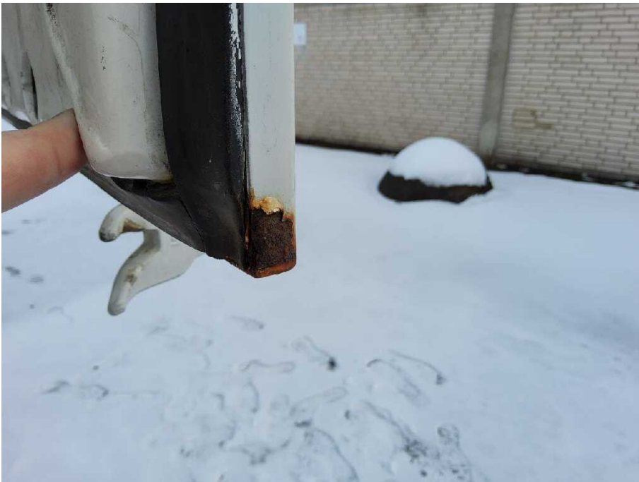
Bild 27 rechte Seite Tür hinten rechts korrodiert
