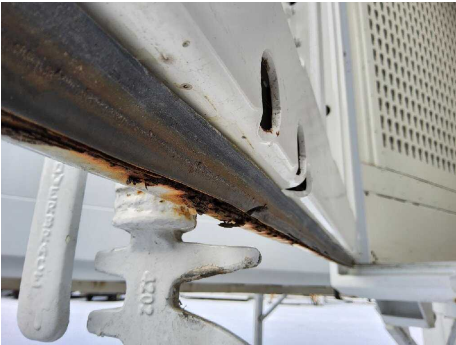
Bild 11 linke Seite Tür hinten links korrodiert
