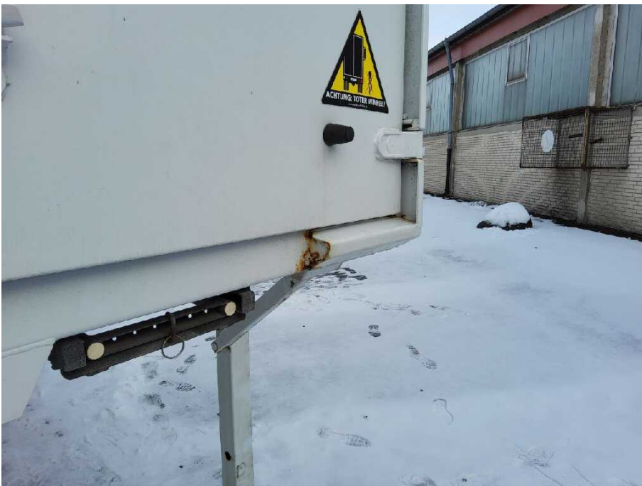
Bild 14 Fahrzeugfront Fahrzeugrahmen korrodiert
