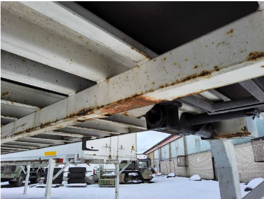
Bild 16 Aufbau Bodenrahmen hinten korrodiert
