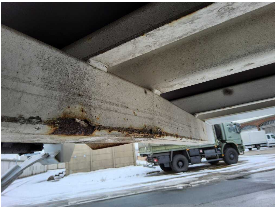
Bild 16 Aufbau Bodenrahmen hinten korrodiert
