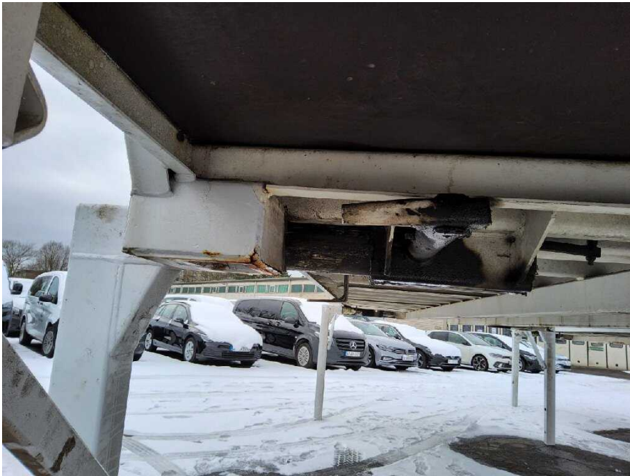
Bild 11 Aufbau Containerverriegelung korrodiert
