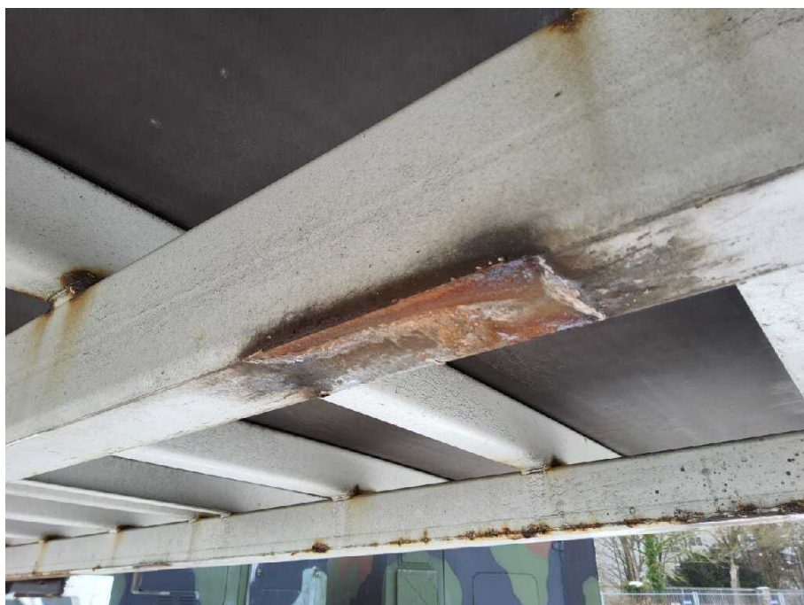
Bild 25 Aufbau Bodenrahmen hinten korrodiert
