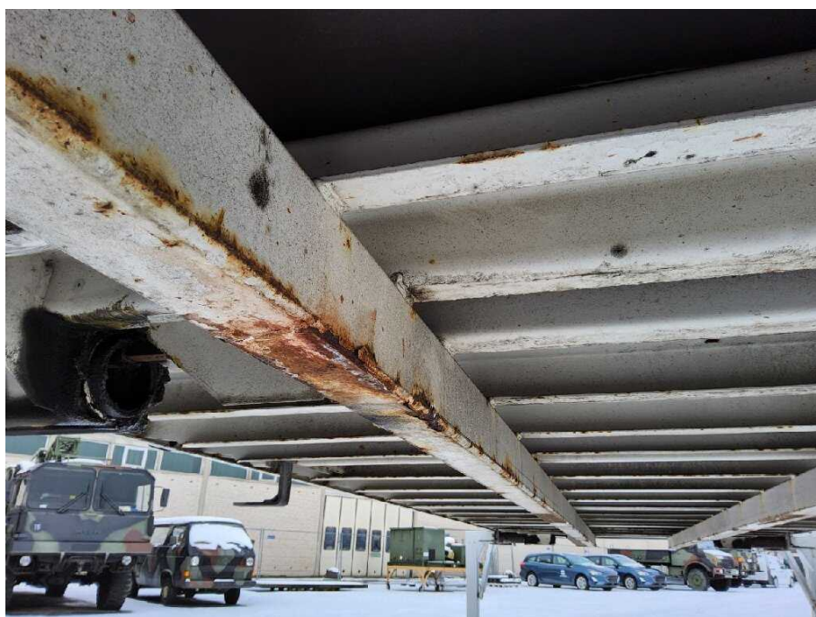
Bild 16 Aufbau Bodenrahmen hinten korrodiert
