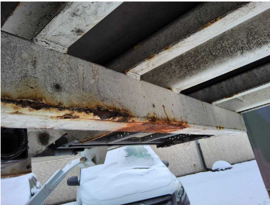
Bild 27 Aufbau Bodenrahmen hinten korrodiert
