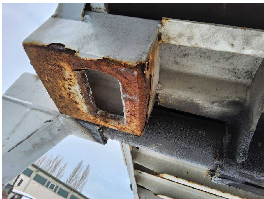
Bild 15 Aufbau Containerverriegelung korrodiert
