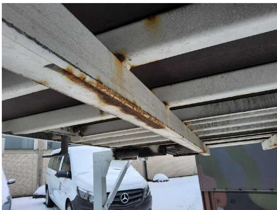
Bild 26 Aufbau Bodenrahmen hinten korrodiert
