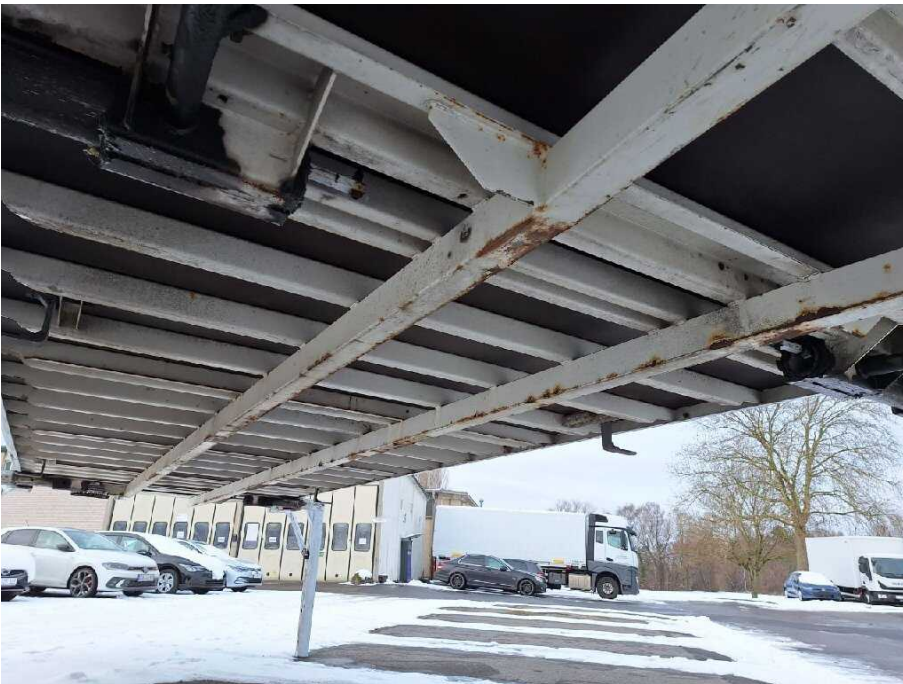
Bild 20 Aufbau Bodenrahmen hinten korrodiert
