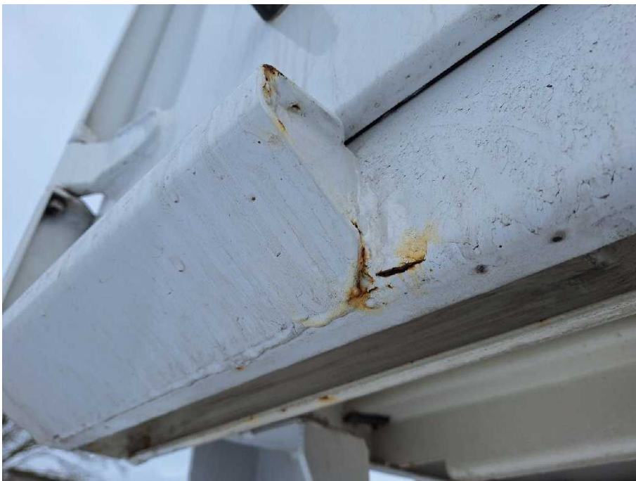
Bild 24 Fahrzeugfront Fahrzeugrahmen korrodiert
