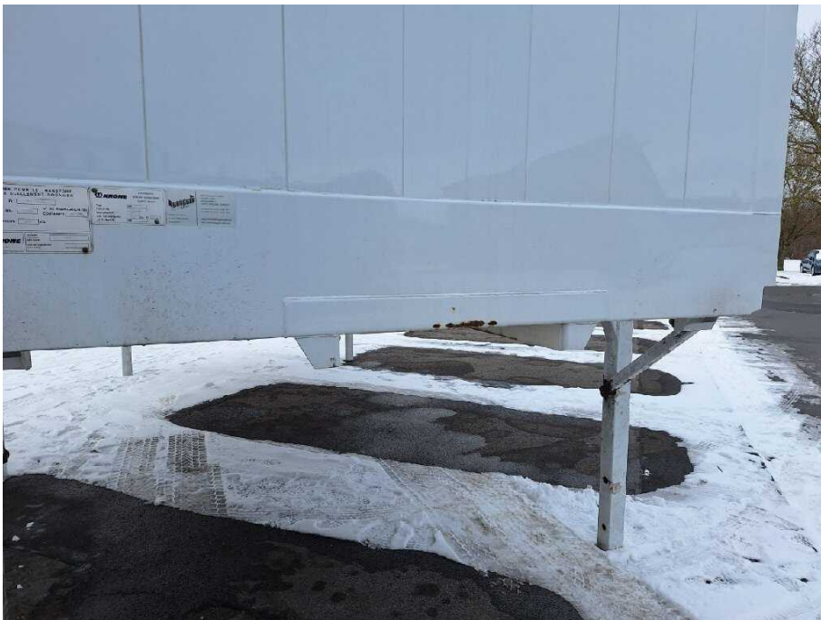
Bild 21 Fahrzeugfront Fahrzeugrahmen korrodiert
