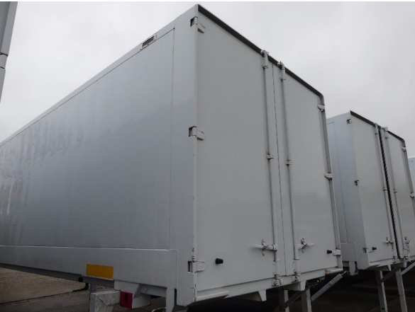
Bild 21: Eckbeplankung links Korrosion - instandsetzen und lackieren
