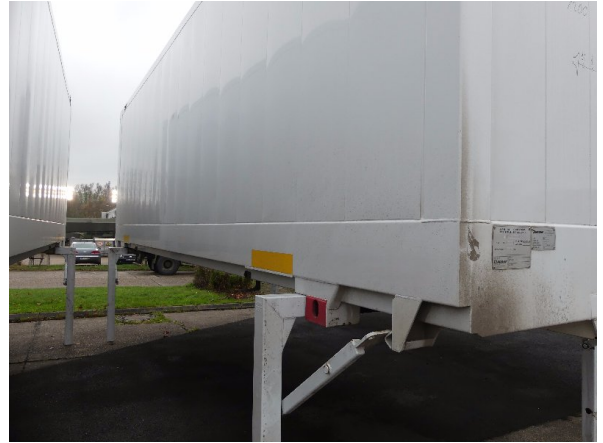
Bild 14: Abdichtung Seitenwand beschädigt - erneuern
