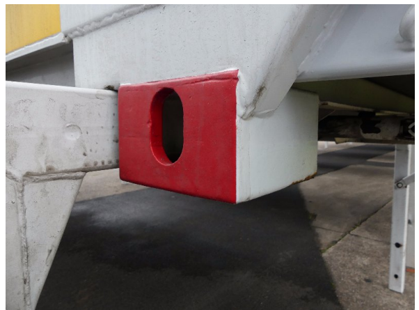
Bild 32: Karosserie Delle / Kratzer / Abschürfung- ohne Reparatur
