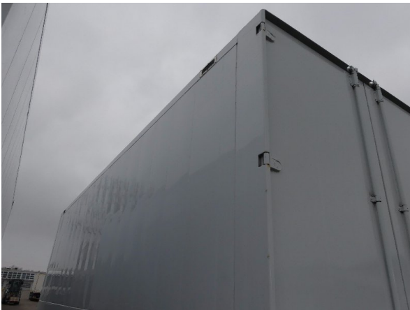
Bild 25: Karosserie Delle / Kratzer / Abschürfung- ohne Reparatur
