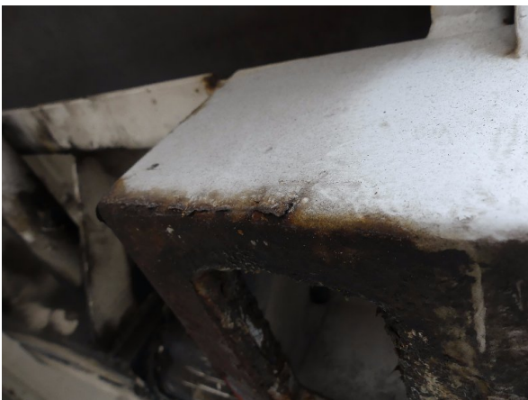
Bild 27: Karosserie Delle / Kratzer / Abschürfung- ohne Reparatur
