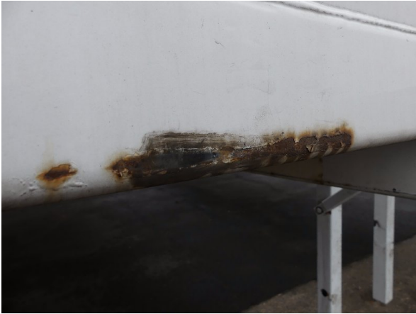
Bild 13: Frontwand Korrosion - instandsetzen und lackieren
