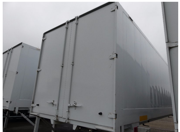
Bild 18: Eckbeplankung rechts Korrosion - instandsetzen und lackieren
