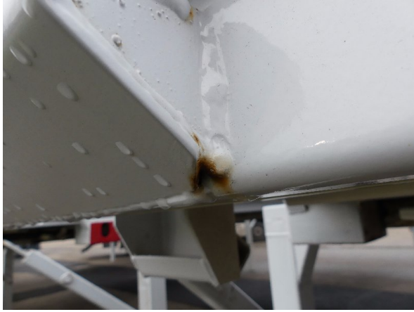
Bild 23: Eckbeplankung unterhalb links Korrosion - instandsetzen und lackieren
