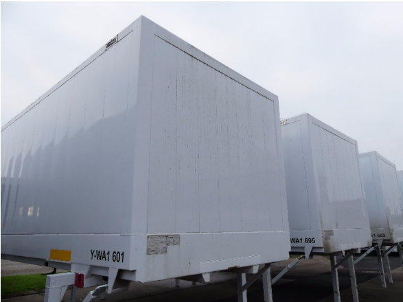
Bild 12: Frontwand Korrosion - instandsetzen und lackieren
