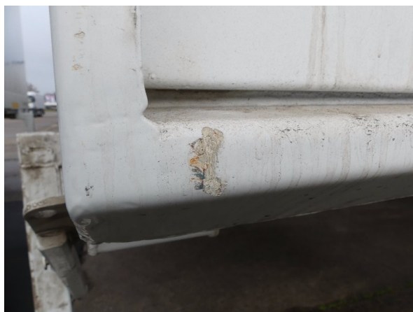
Bild 18: Eckbeplankung unterhalb links Korrosion - instandsetzen und lackieren
