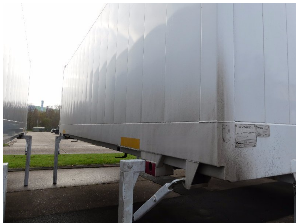
Bild 14: Abdichtung Seitenwand links und rechts beschädigt - erneuern
