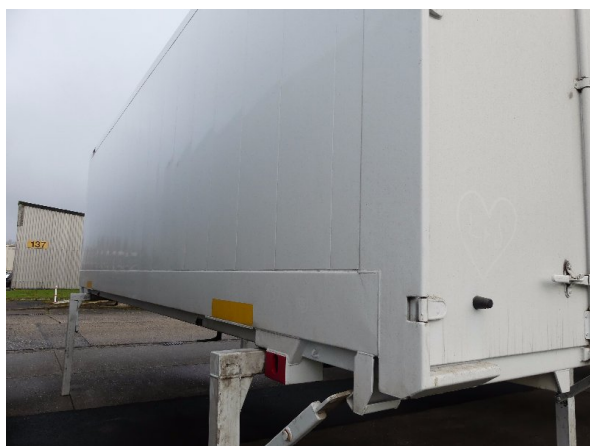
Bild 16: Abdichtung Seitenwand links und rechts beschädigt - erneuern
