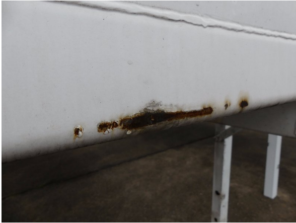
Bild 13: Frontwand Korrosion - instandsetzen und lackieren
