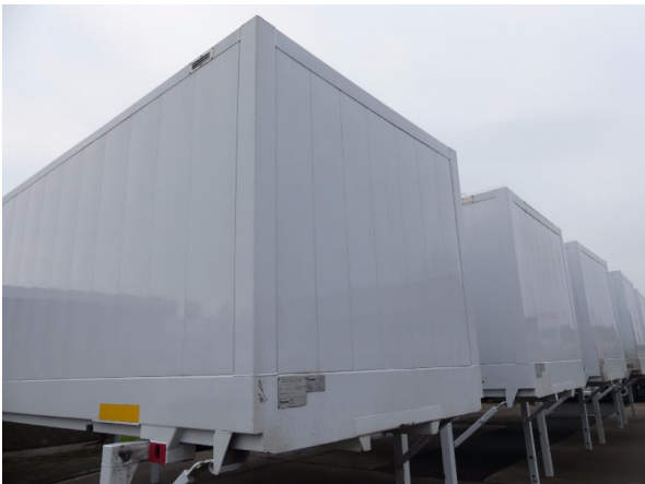
Bild 12: Frontwand Korrosion - instandsetzen und lackieren
