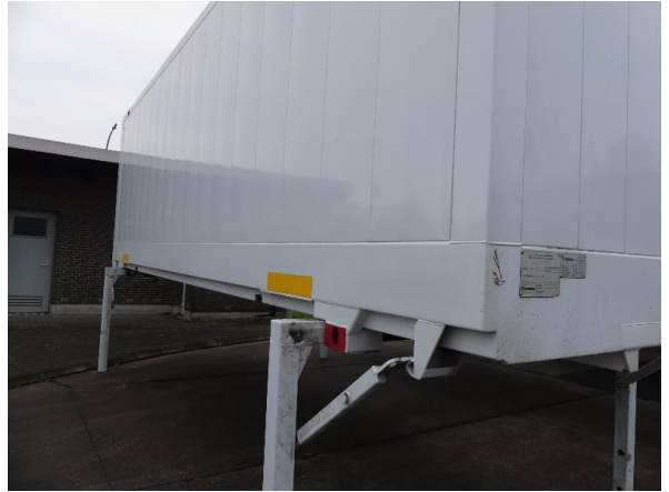
Bild 14: Abdichtung links und rechts beschädigt - erneuern
