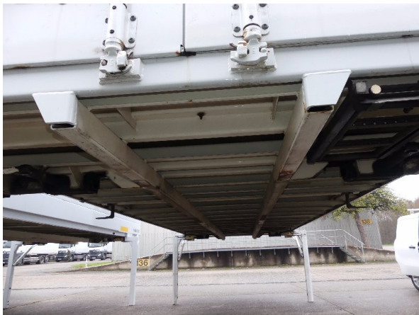
Bild 39: Karosserie Delle / Kratzer / Abschürfung- ohne Reparatur
