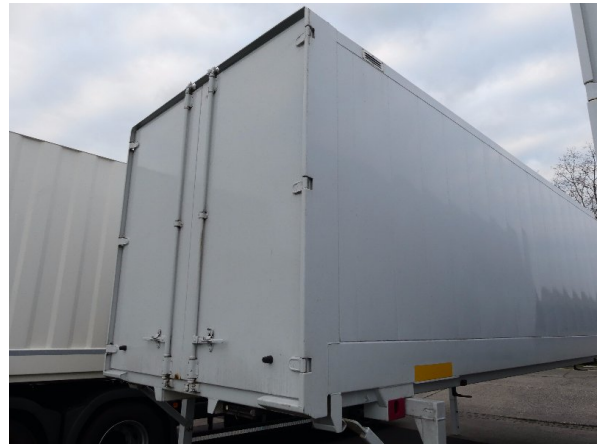
Bild 20: Eckbeplankung rechts Abschürfungen / Korrosion - instandsetzen und lackieren
