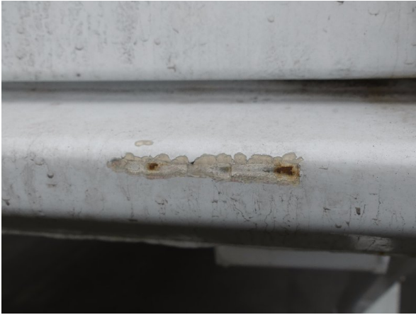
Bild 23: Eckbeplankung rechts Abschürfungen / Korrosion - instandsetzen und lackieren
