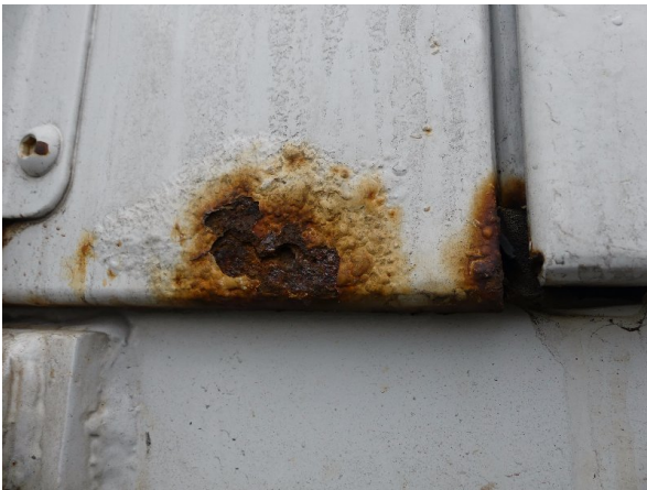
Bild 25: Hecktür links Korrosion - instandsetzen und lackieren
