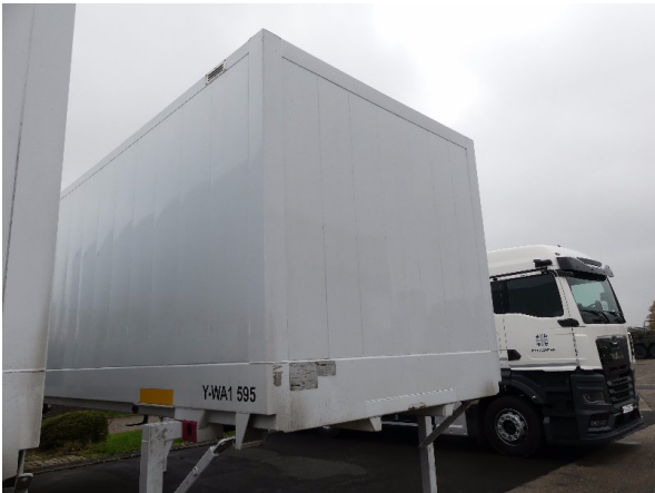
Bild 12: Frontwand Korrosion - instandsetzen und lackieren
