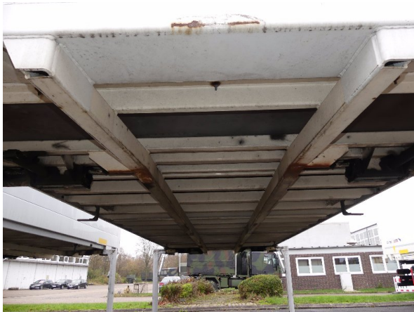
Bild 35: Karosserie Delle / Kratzer / Abschürfung- ohne Reparatur
