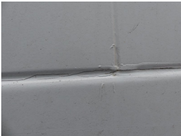
Bild 15: Abdichtung links und rechts beschädigt - erneuern
