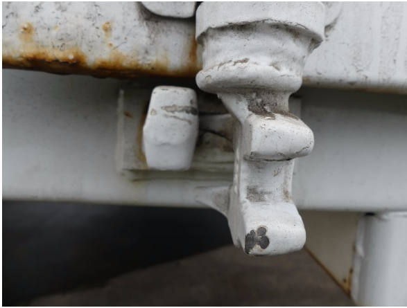
Bild 13: Hecktür rechts Korrosion / schließt nicht - instandsetzen und lackieren
