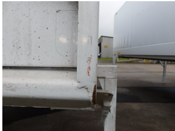
Bild 22: Eckbeplankung unterhalb rechts Korrosion - instandsetzen und lackieren
