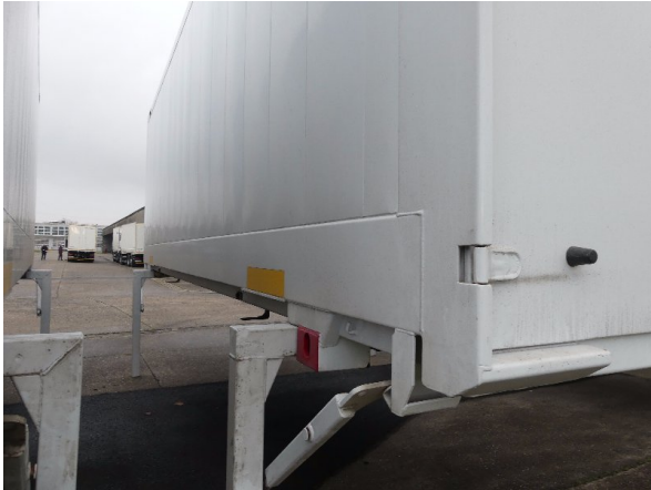
Bild 19: Abdichtung links und rechts beschädigt - erneuern
