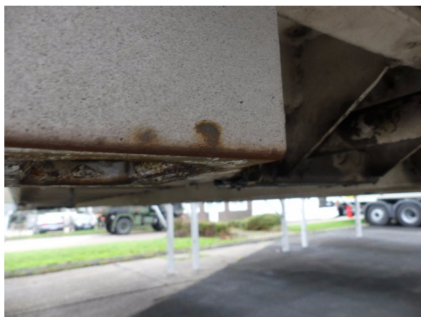
Bild 34: Karosserie Delle / Kratzer / Abschürfung- ohne Reparatur
