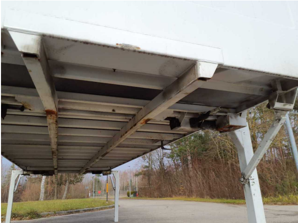
Gebrauchsspur 1: Karosserie: Karosserie - beschädigt - kein Abzug
