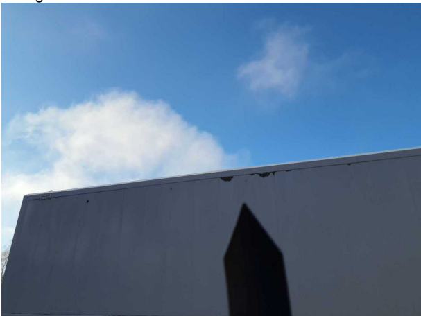
Gebrauchsspur 1: Karosserie: Karosserie - beschädigt - kein Abzug
