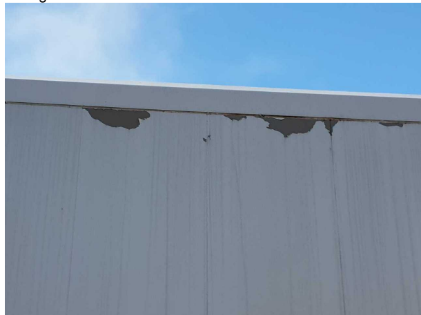
Gebrauchsspur 1: Karosserie: Karosserie - beschädigt - kein Abzug
