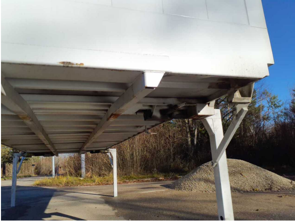
Gebrauchsspur 1: Karosserie: Karosserie - beschädigt - kein Abzug
