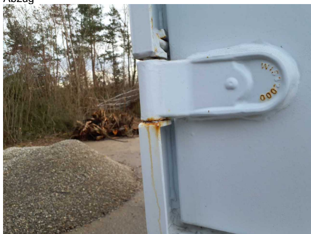
Gebrauchsspur 1: Karosserie: Karosserie - beschädigt - kein Abzug
