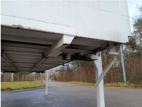
Gebrauchsspur 1: Karosserie: Karosserie - beschädigt - kein Abzug
