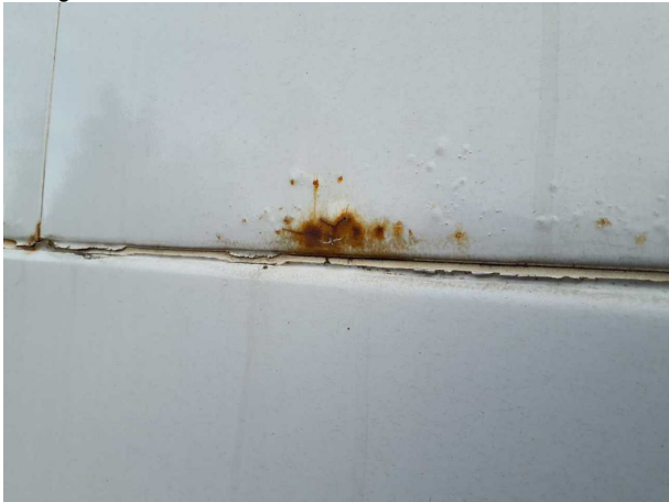
Gebrauchsspur 1: Karosserie: Karosserie - beschädigt - kein Abzug
