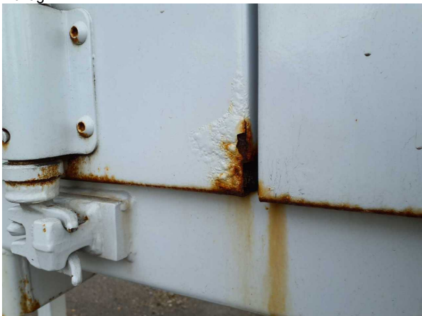
Gebrauchsspur 1: Karosserie: Karosserie - beschädigt - kein Abzug
