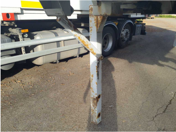
Beschädigung 1: Aufbau: Aufbau - Korrosion - instandsetzen und lackieren
