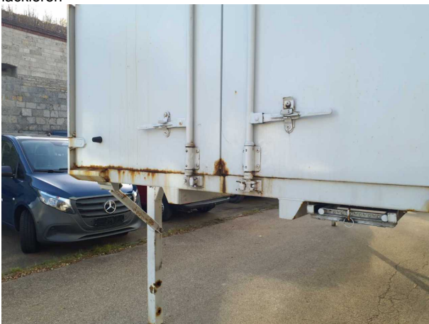
Beschädigung 1: Aufbau: Aufbau - Korrosion - instandsetzen und lackieren
