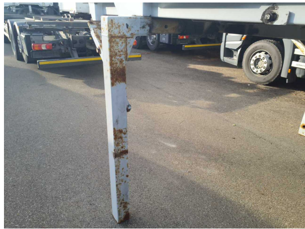
Beschädigung 1: Aufbau: Aufbau - Korrosion - instandsetzen und lackieren
