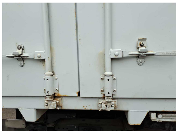
Beschädigung 1: Aufbau: Aufbau - Korrosion - lackieren
