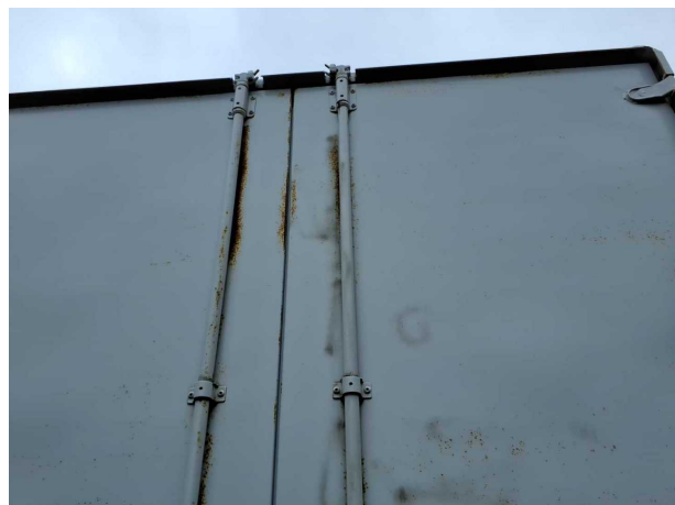
Beschädigung 1: Aufbau: Aufbau - Korrosion - lackieren
