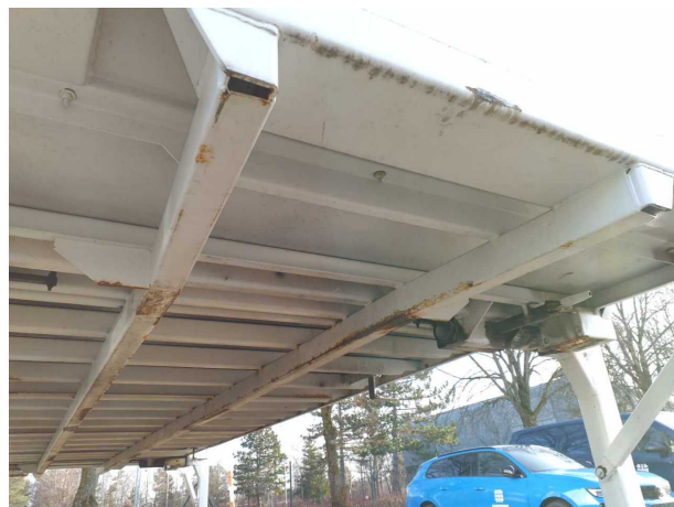
Gebrauchsspur 1: Karosserie: Karosserie - Korrosion - kein Abzug
