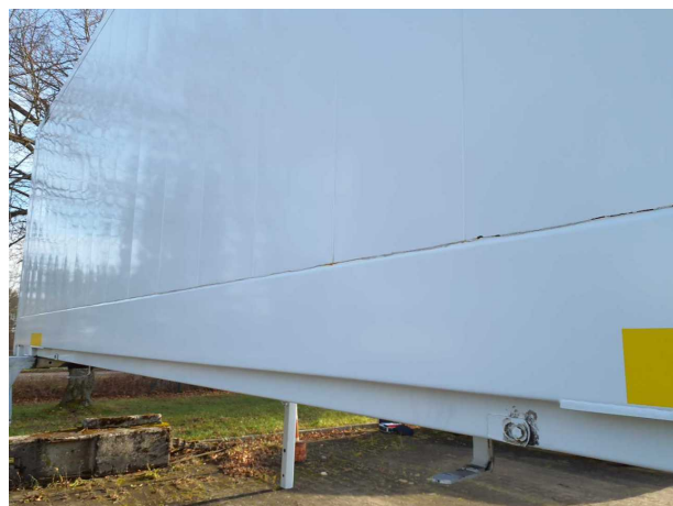
Gebrauchsspur 1: Karosserie: Karosserie - Korrosion - kein Abzug
