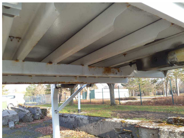
Gebrauchsspur 1: Karosserie: Karosserie - Korrosion - kein Abzug
