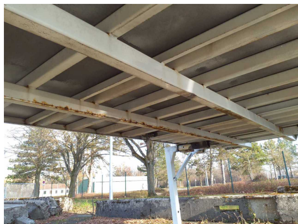
Gebrauchsspur 1: Karosserie: Karosserie - Korrosion - kein Abzug
