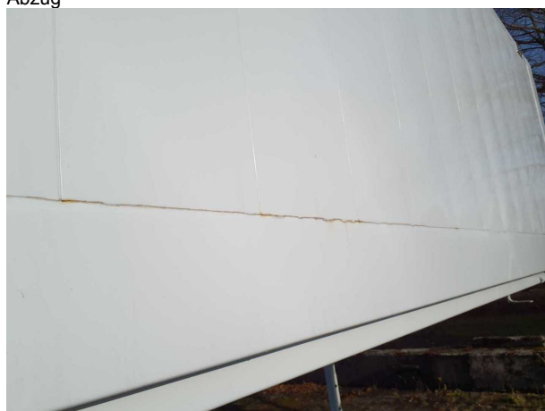
Gebrauchsspur 1: Karosserie: Karosserie - Korrosion - kein Abzug
