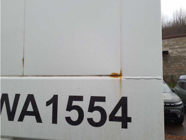
Beschädigung 2: Aufbau: Aufbau - Korrosion - instandsetzen und lackieren
