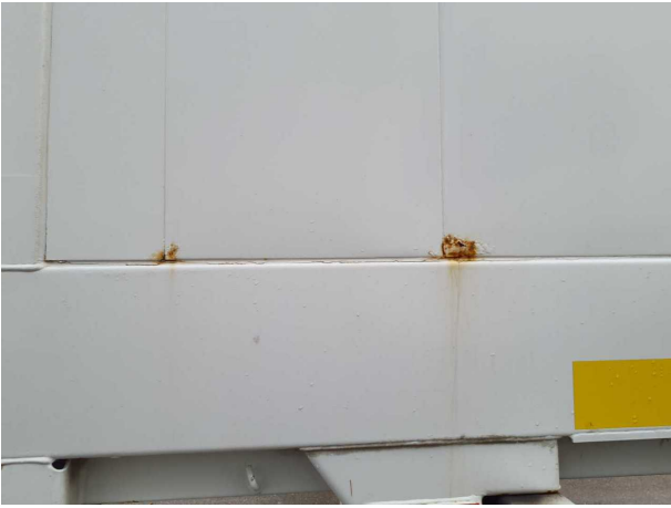
Beschädigung 2: Aufbau: Aufbau - Korrosion - instandsetzen und lackieren
