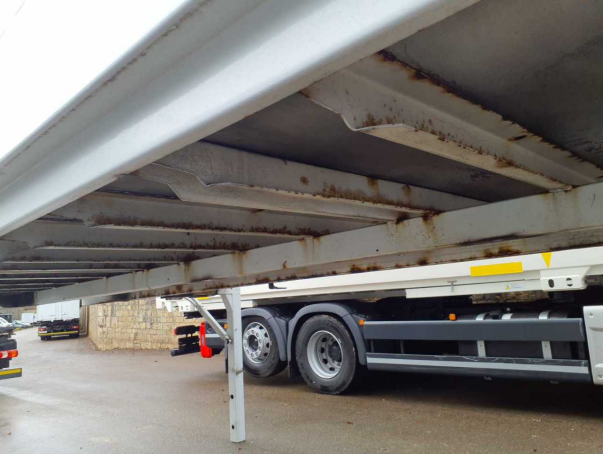
Beschädigung 2: Aufbau: Aufbau - Korrosion - instandsetzen und lackieren
