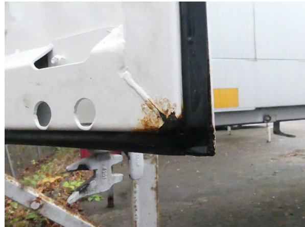
Bild 16: Tür rechts Korrosion - teillackieren
