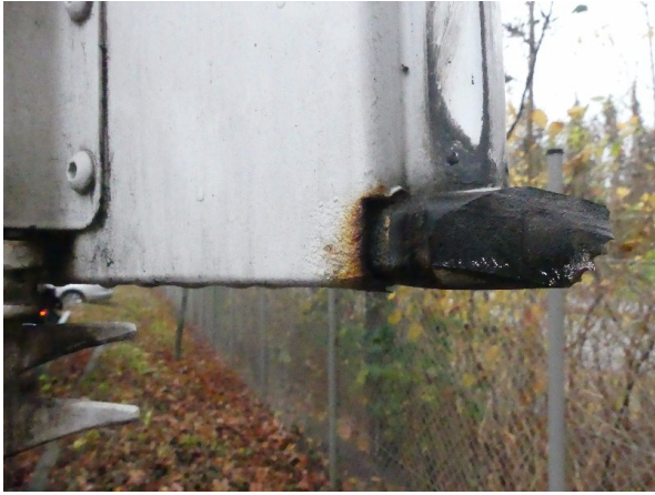
Bild 13: Tür links Korrosion - teillackieren
