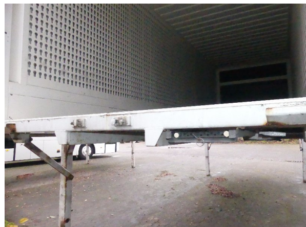
Bild 6: Portalrahmen unten Korrosion - lackieren
