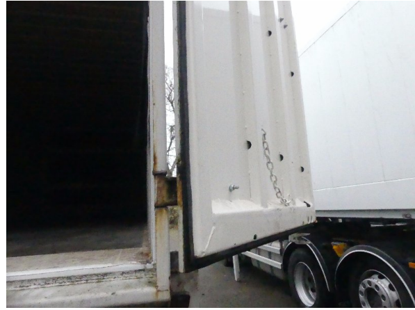
Bild 14: Tür rechts Korrosion - teillackieren
