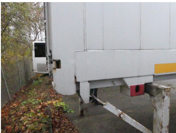
Bild 17: Portalrahmen rechts Korrosion - teillackieren
