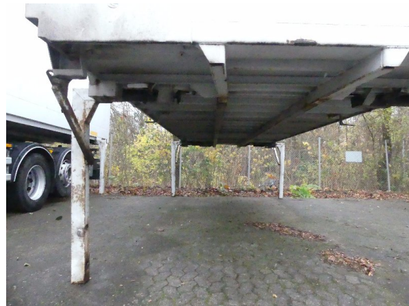
Bild 22: Rahmen und Stützbeine Korrosion - ohne Reparatur
