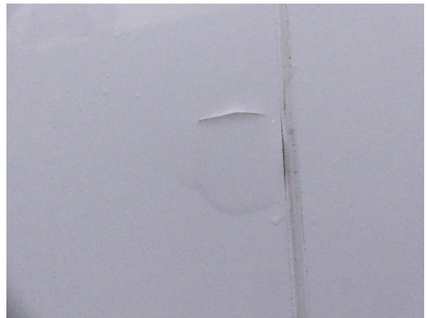
Bild 28: Seitenwand rechts Lackabplatzung - teillackieren
