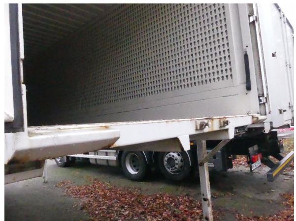
Bild 10: Portalrahmen unten Korrosion - lackieren
