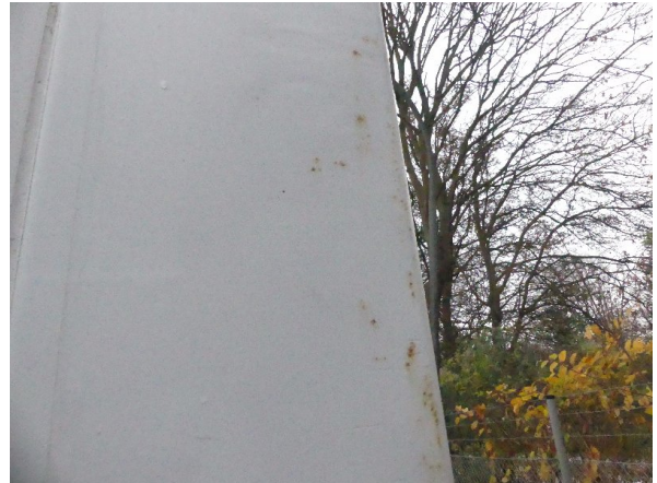
Bild 34: Portalrahmen links Flugrost - teillackieren
