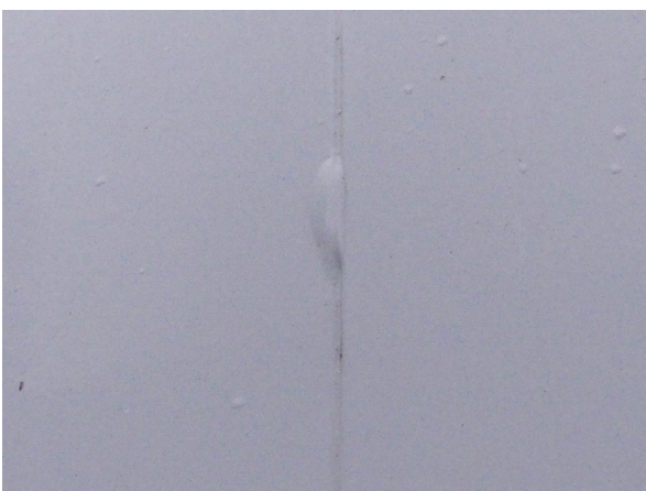
Bild 29: Seitenwand rechts Lackabplatzung - teillackieren
