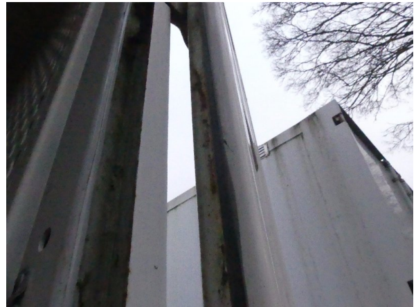
Bild 22: Tür rechts Korrosion - teillackieren
