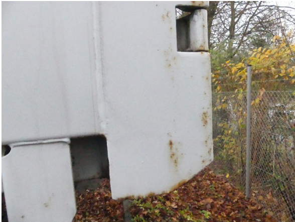
Bild 33: Portalrahmen links Flugrost - teillackieren
