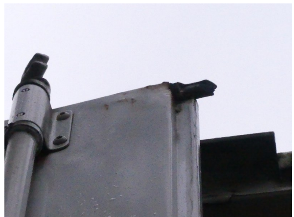
Bild 18: Tür links Korrosion - teillackieren
