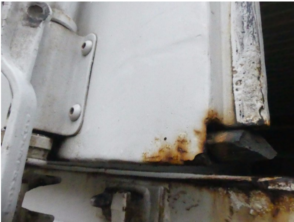
Bild 15: Tür links Korrosion - teillackieren
