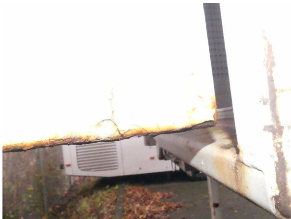
Bild 15: Tür rechts Korrosion - teillackieren
