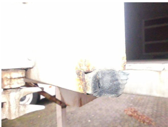
Bild 11: Tür links Korrosion - teillackieren
