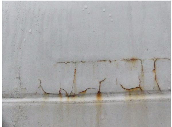
Bild 26: Seitenwand links Rostansatz, Korrosionsschaden nicht sach,- fachgerecht instandgesetzt, Korrosion - teillackieren
