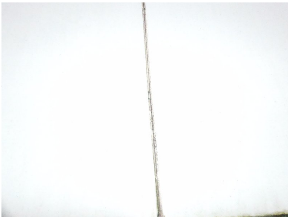
Bild 21: Seitenwand rechts Nahtabdichtung fehlt - instandsetzen
