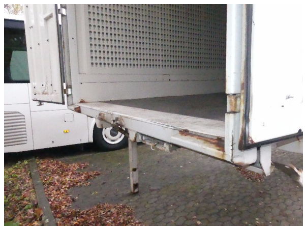
Bild 6: Portalrahmen unten Korrosion - lackieren
