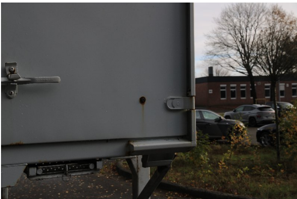
Bild 5: Anschlagpuffer Tür re. fehlt / weggerostet - ersetzen
