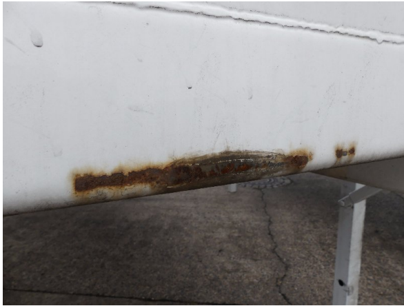
Bild 13: Frontwand Korrosion - instandsetzen und lackieren
