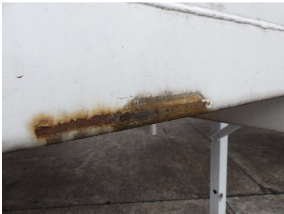
Bild 15: Frontwand Korrosion - instandsetzen und lackieren
