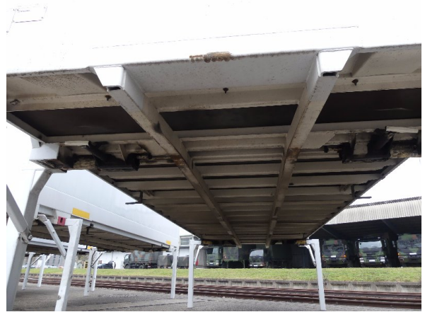
Bild 30: Karosserie Delle / Kratzer / Abschürfung ohne Reparatur
