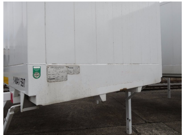
Bild 16: Abdichtung Frontwand, Seitenwand links und rechts beschädigt - erneuern
