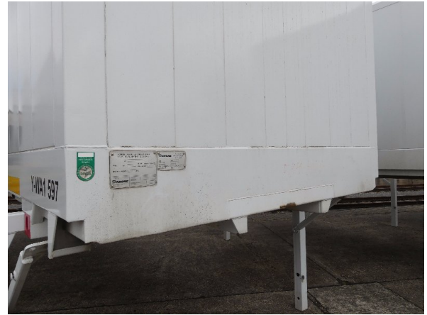
Bild 14: Frontwand Korrosion - instandsetzen und lackieren
