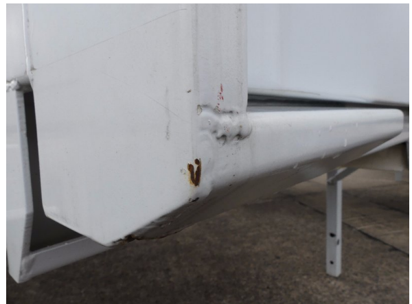
Bild 26: Eckbeplankung links Abschürfung - instandsetzen und lackieren
