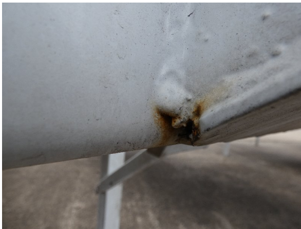
Bild 15: Heckbereich Kratzer/Korrosion - instandsetzen und lackieren
