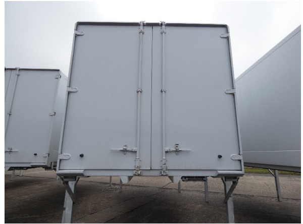
Bild 14: Heckbereich Kratzer/Korrosion - instandsetzen und lackieren
