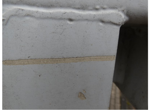
Bild 20: Seitenwand Kratzer/Korrosion - instandsetzen und lackieren
