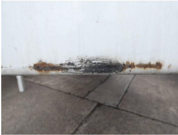
Bild 13: Frontbereich Kratzer/Korrosion - instandsetzen und lackieren
