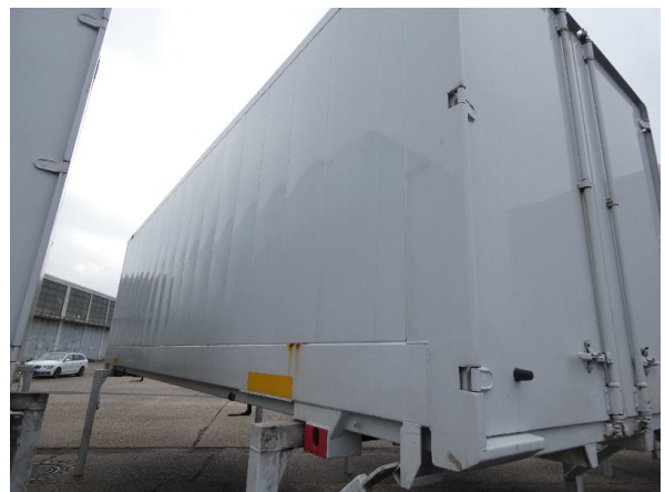
Bild 18: Seitenwand Kratzer/Korrosion - instandsetzen und lackieren
