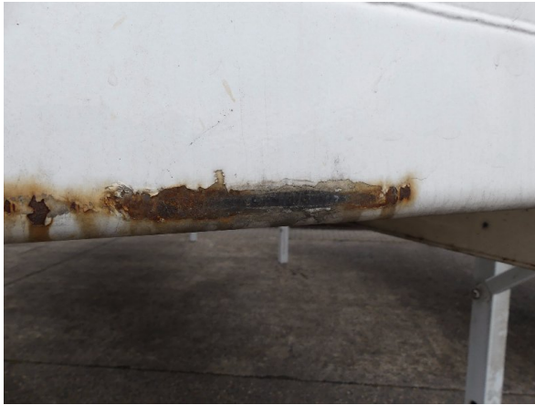
Bild 13: Frontwand Korrosion - instandsetzen und lackieren
