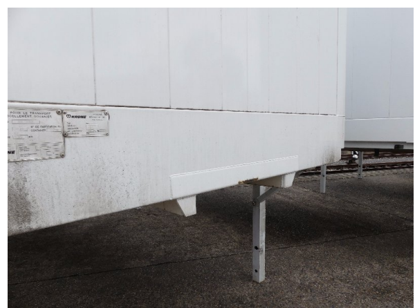
Bild 12: Frontwand Korrosion - instandsetzen und lackieren
