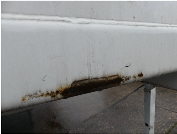
Bild 13: Frontwand Korrosion - instandsetzen und lackieren
