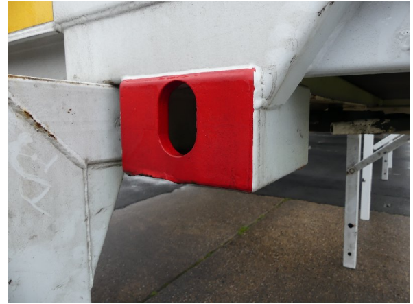
Bild 30: Aufnahmen Korrosion - instandsetzen und lackieren
