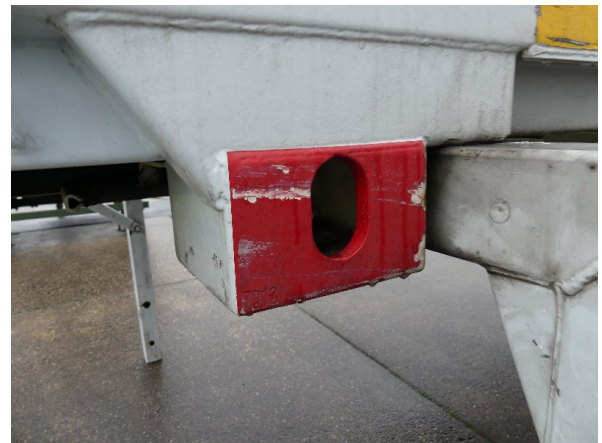
Bild 32: Aufnahmen Korrosion - instandsetzen und lackieren
