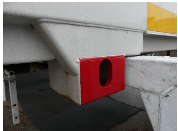
Bild 28: Aufnahmen Korrosion - instandsetzen und lackieren
