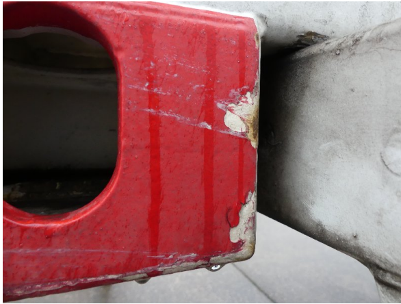
Bild 33: Aufnahmen Korrosion - instandsetzen und lackieren
