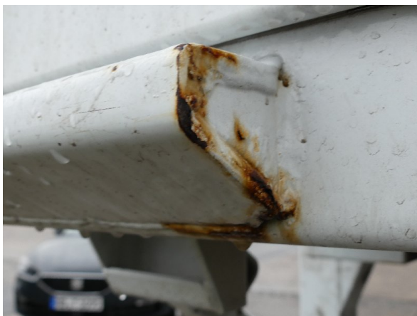
Bild 27: Eckbeplankung links Korrosion - instandsetzen und lackieren
