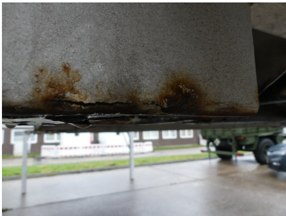
Bild 35: Aufnahmen Korrosion - instandsetzen und lackieren
