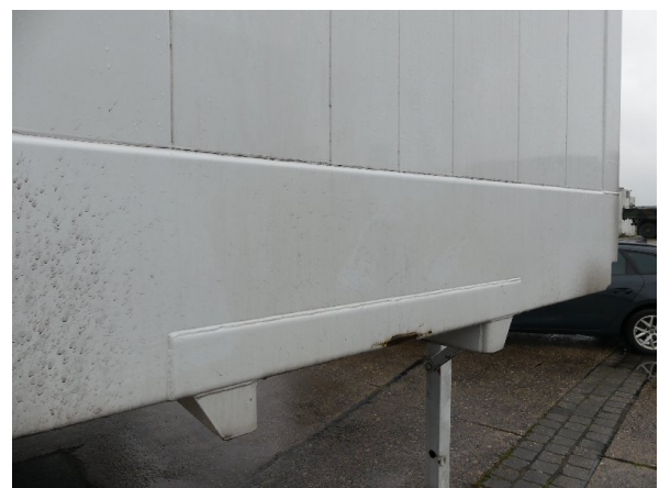
Bild 12: Frontwand Korrosion - instandsetzen und lackieren
