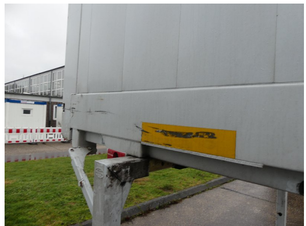
Bild 18: Seitenwand Korrosion - instandsetzen und lackieren
