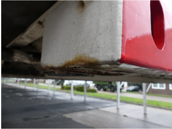
Bild 29: Aufnahmen Korrosion - instandsetzen und lackieren
