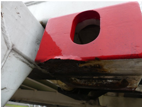
Bild 31: Aufnahmen Korrosion - instandsetzen und lackieren
