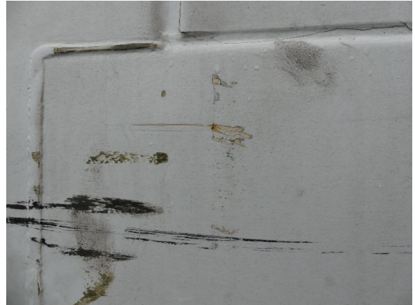
Bild 20: Seitenwand Korrosion - instandsetzen und lackieren
