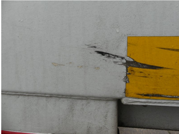
Bild 19: Seitenwand Korrosion - instandsetzen und lackieren
