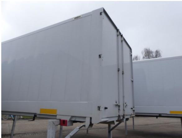
Bild 21: Eckbeplankung links Korrosion - instandsetzen und lackieren
