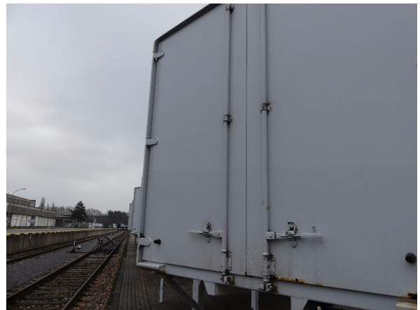
Bild 26: Hecktür links Korrosion - instandsetzen und lackieren
