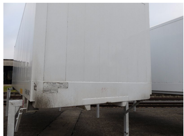
Bild 12: Frontwand Korrosion - instandsetzen und lackieren
