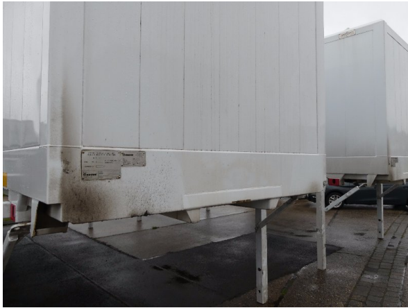
Bild 13: Frontwand Korrosion - instandsetzen und lackieren
