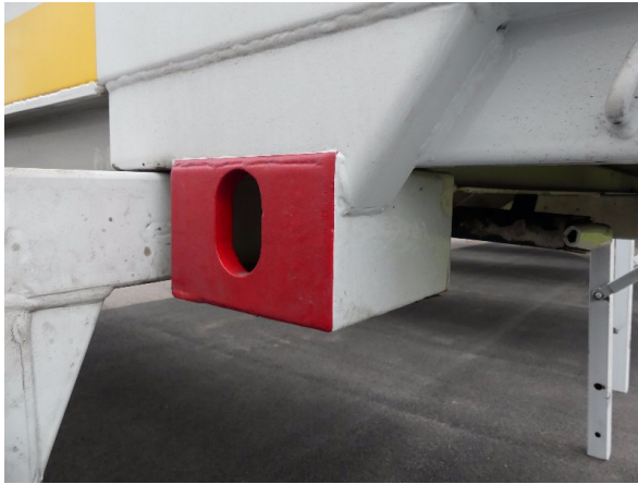
Bild 33: Karosserie / Innenraum Delle / Kratzer / Steinschlag / Abschürfung-ohne Reparatur
