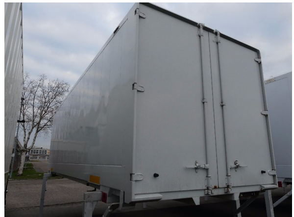
Bild 26: Eckbeplankung unterhalb links Korrosion - instandsetzen und lackieren
