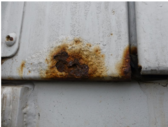
Bild 25: Hecktür links Korrosion - instandsetzen und lackieren
