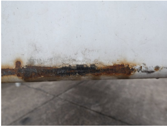
Bild 13: Frontbereich Kratzer/Korrosion - instandsetzen und lackieren
