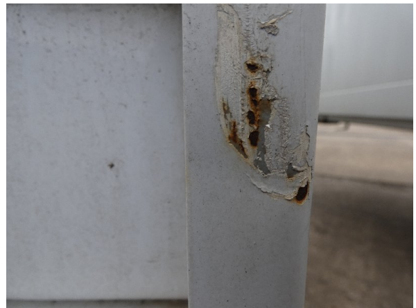
Bild 16: Heckbereich Kratzer/Korrosion - instandsetzen und lackieren
