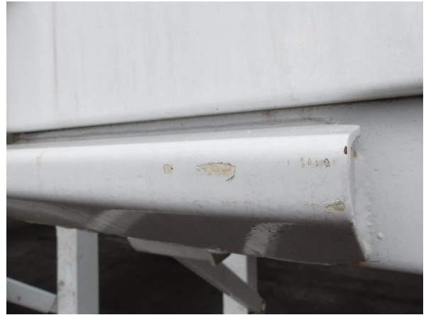
Bild 24: Eckbeplankung links Abschürfung - instandsetzen und lackieren
