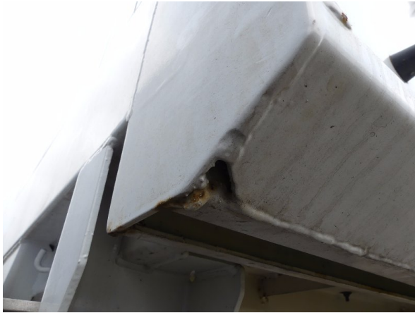
Bild 23: Eckbeplankung links Abschürfung - instandsetzen und lackieren
