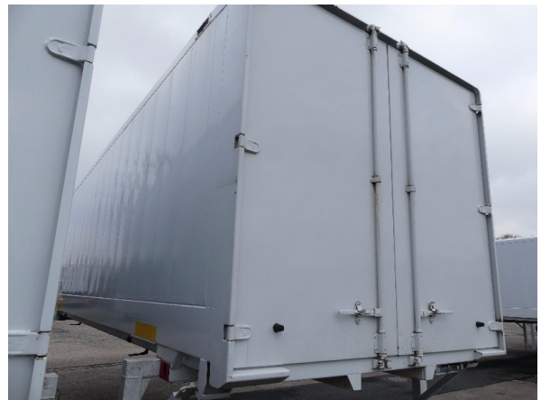
Bild 22: Eckbeplankung links Abschürfung - instandsetzen und lackieren
