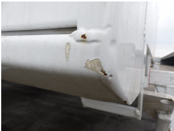
Bild 21: Eckbeplankung rechts Abschürfung - instandsetzen und lackieren
