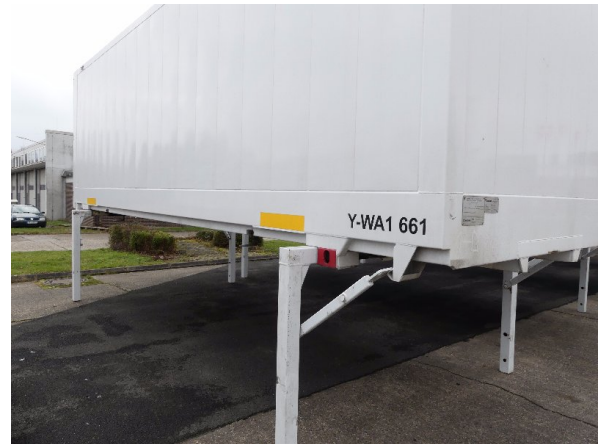
Bild 14: Abdichtung Seitenwand links und rechts beschädigt - erneuern
