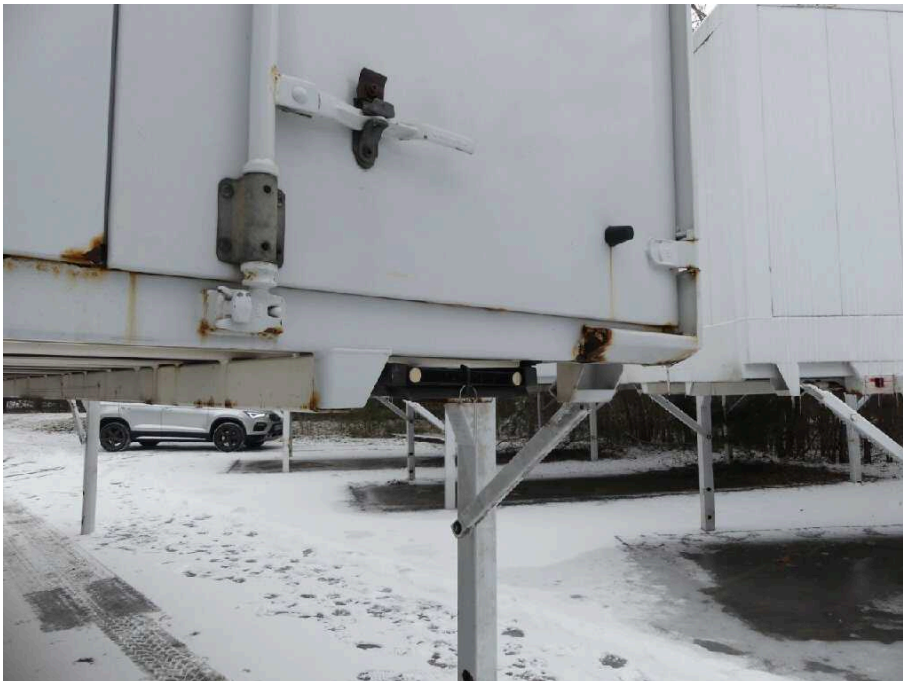
Bild 36 Fahrzeugheck Heckflügeltür rechts stark korrodiert
