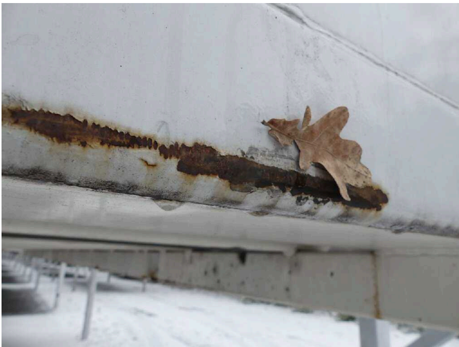
Bild 10 Aufbau Bodenrahmen vorne korrodiert
