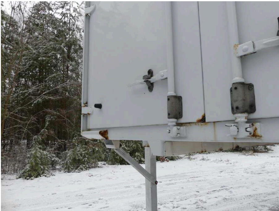
Bild 22 Fahrzeugheck Heckflügeltür links stark korrodiert
