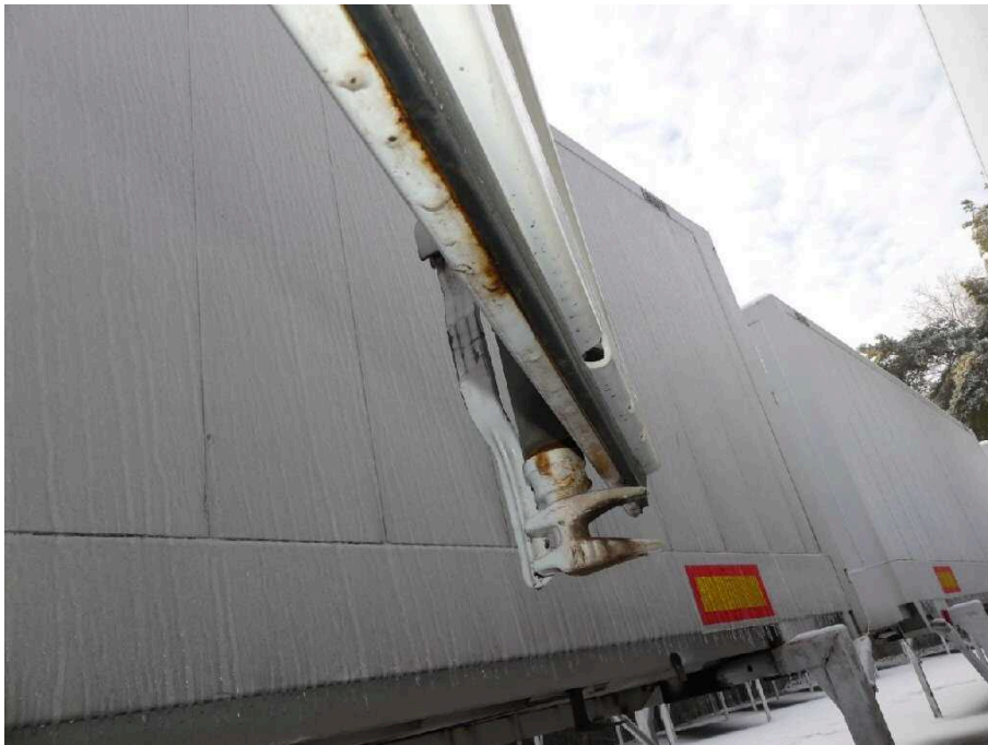
Bild 41 Fahrzeugheck Heckflügeltür rechts korrodiert
