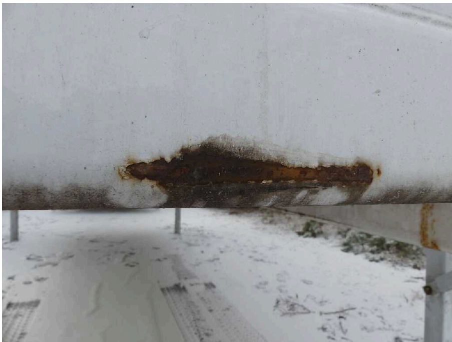
Bild 10 Aufbau Bodenrahmen vorne korrodiert
