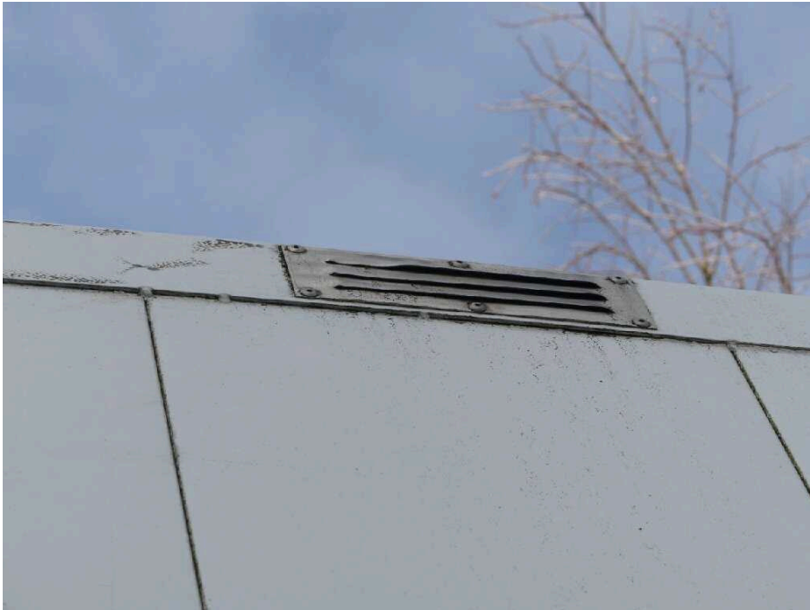
Bild 35 rechte Seite Seitenwand rechts Lüftungsgitter hi.re. oben deformiert
