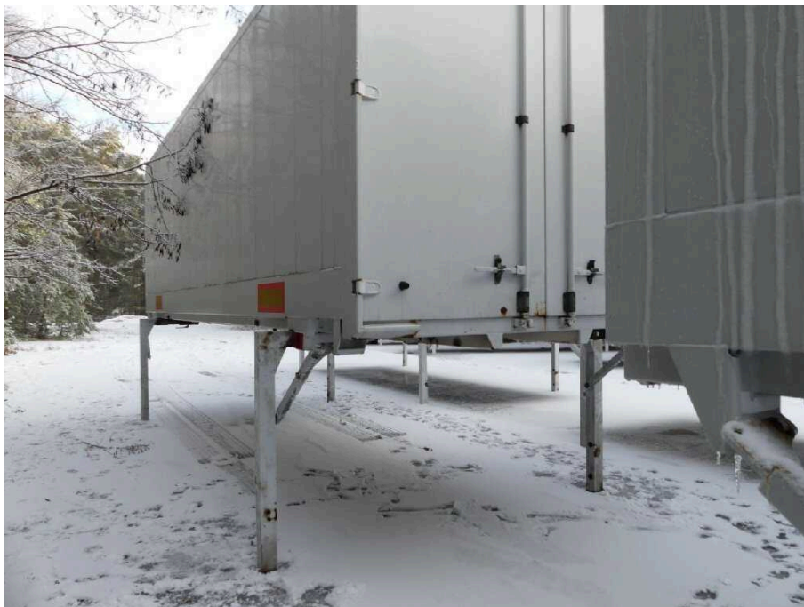
Bild 16 Fahrzeugheck Heckflügeltür links stark korrodiert und keine fachgerechte Reparatur
