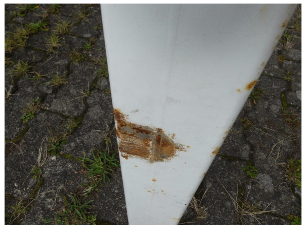
Bild 38: Stützen rundum Korrosion-instandsetzen und lackieren
