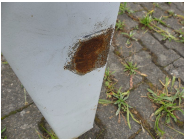
Bild 37: Stützen rundum Korrosion-instandsetzen und lackieren
