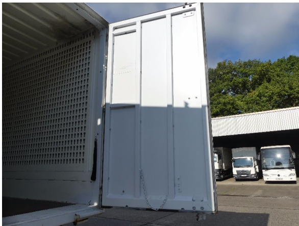
Bild 15: Tür Korrosion - instandsetzen und lackieren
