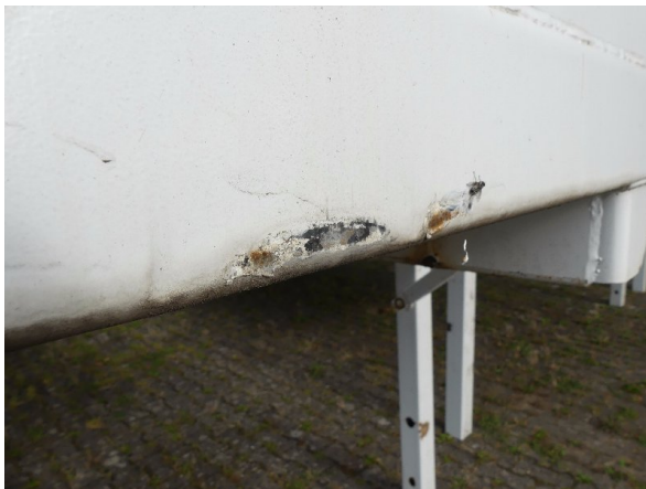
Bild 31: Frontwand Korrosion - instandsetzen und lackieren
