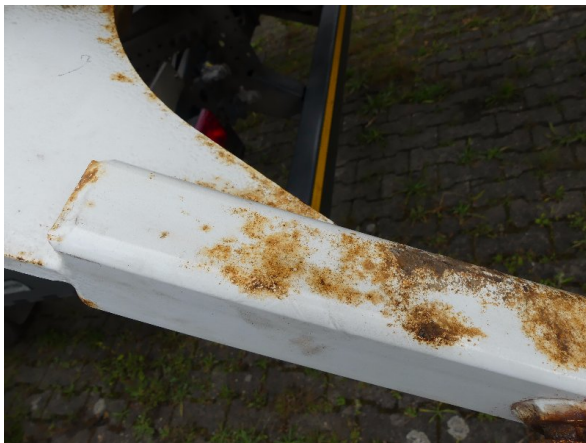
Bild 35: Stützen rundum Korrosion-instandsetzen und lackieren
