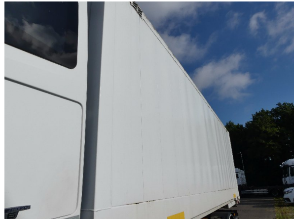
Bild 26: Abdichtung links und rechts beschädigt - erneuern
