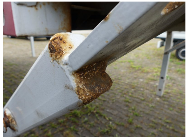
Bild 36: Stützen rundum Korrosion-instandsetzen und lackieren
