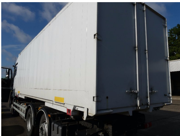
Bild 17: Eckbeplankung links Korrosion - instandsetzen und lackieren
