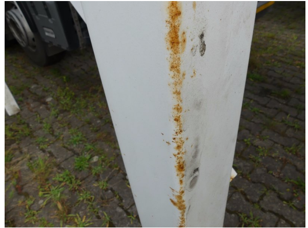
Bild 34: Stützen rundum Korrosion-instandsetzen und lackieren
