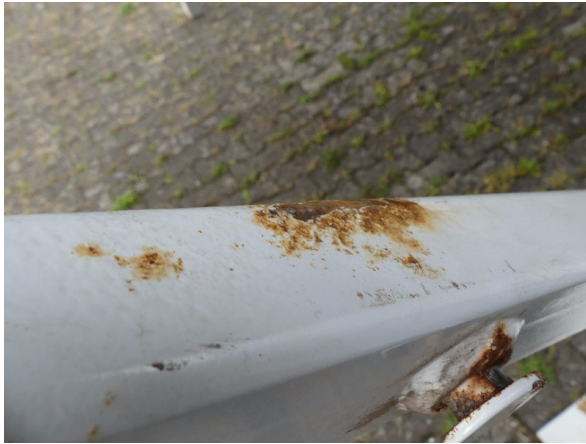
Bild 33: Stützen rundum Korrosion-instandsetzen und lackieren
