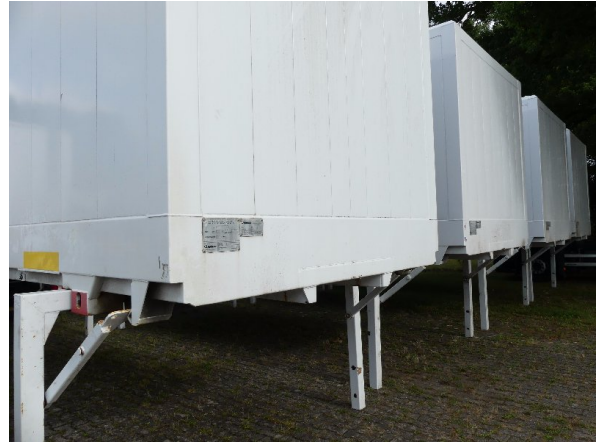
Bild 30: Frontwand Korrosion - instandsetzen und lackieren
