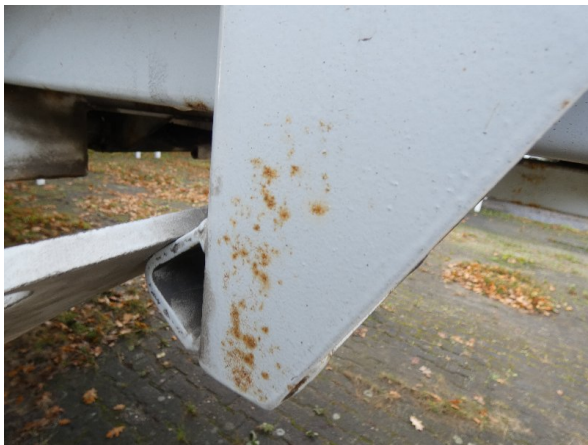
Bild 15: Seitenwand Korrosion - instandsetzen und lackieren
