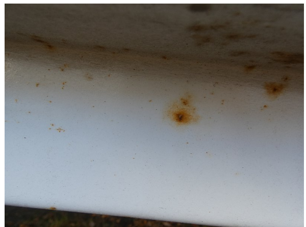
Bild 18: Seitenwand Korrosion - instandsetzen und lackieren
