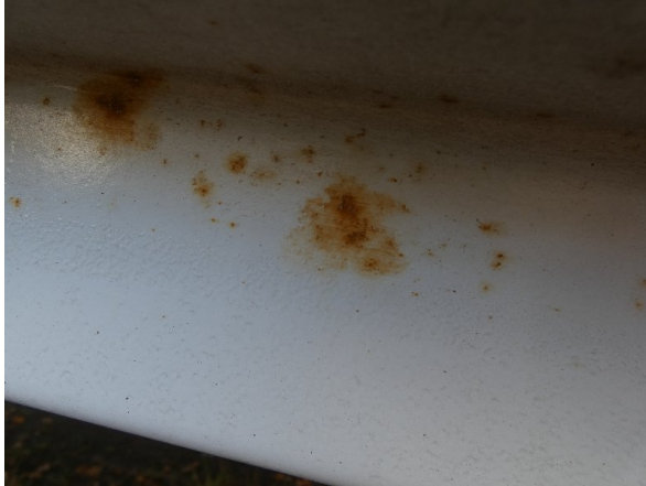
Bild 19: Seitenwand Korrosion - instandsetzen und lackieren
