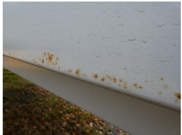
Bild 16: Seitenwand Korrosion - instandsetzen und lackieren
