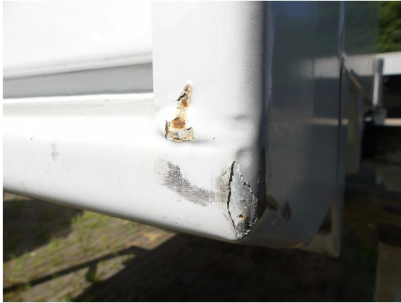
Bild 19: Heckbereich Korrosion - instandsetzen und lackieren
