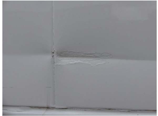
Bild 24: Seitenwand DelleKratzer - instandsetzen und lackieren
