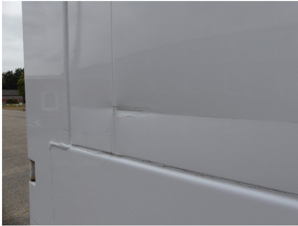
Bild 23: Seitenwand DelleKratzer - instandsetzen und lackieren
