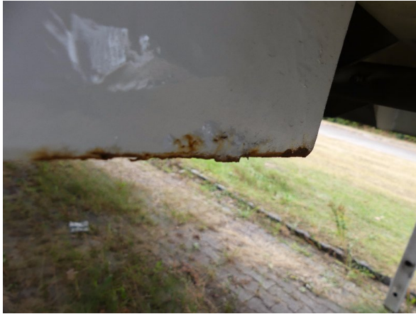
Bild 29: Aufnahmen Korrosion - instandsetzen und lackieren
