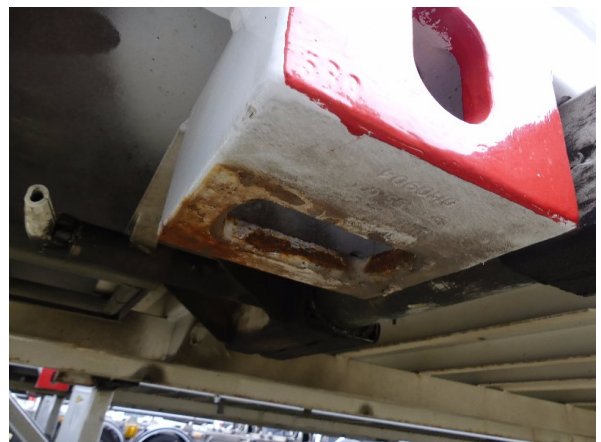
Bild 28: Aufnahmen Korrosion - instandsetzen und lackieren
