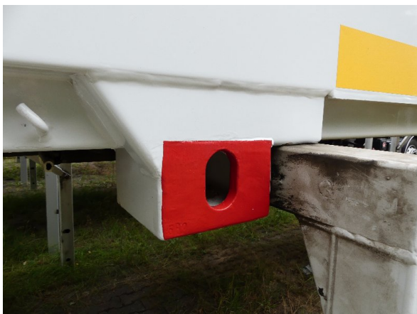
Bild 27: Aufnahmen Korrosion - instandsetzen und lackieren
