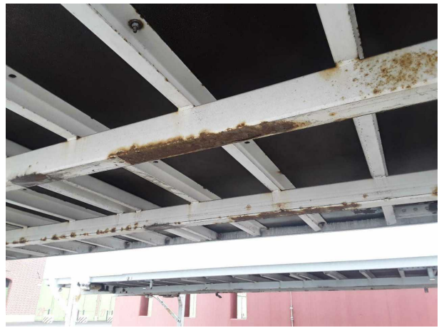
Gebrauchsspur 1: Sonstiges: Fahrzeug - Korrosion
