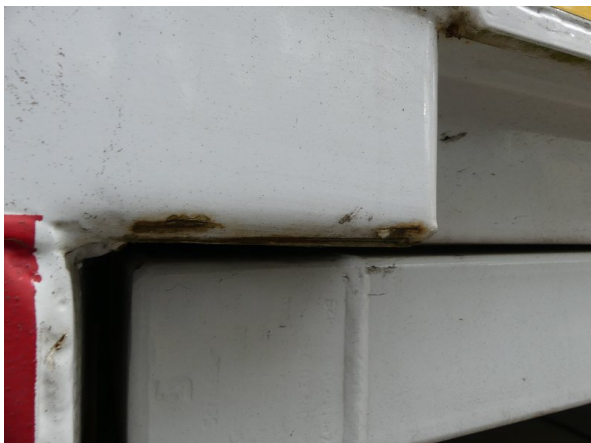
Bild 21: Aufnahmen hinten rechts, hinten links und vorne links Korrosion - instandsetzen und lackieren
