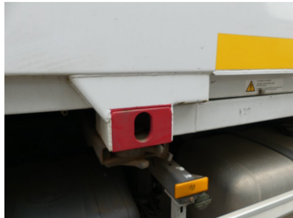
Bild 20: Aufnahmen hinten rechts, hinten links und vorne links Korrosion - instandsetzen und lackieren
