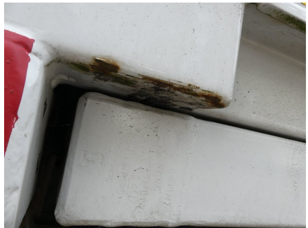
Bild 26: Aufnahme vorne links Korrosion - instandsetzen und lackieren
