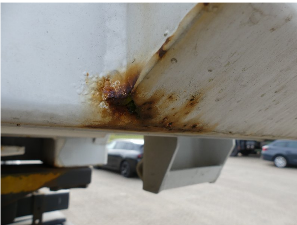
Bild 21: Eckbeplankung rechts Korrosion - instandsetzen und lackieren
