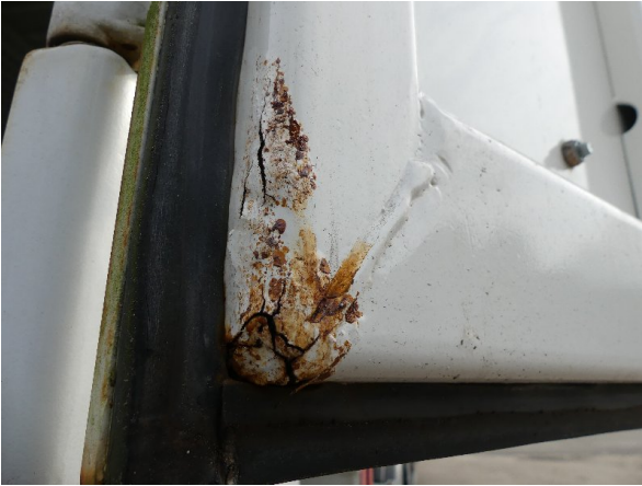
Bild 13: Hecktür rechts Korrosion - instandsetzen und lackieren
