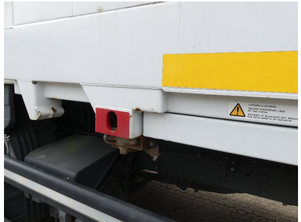
Bild 26: Aufnahmen links Korrosion - instandsetzen und lackieren
