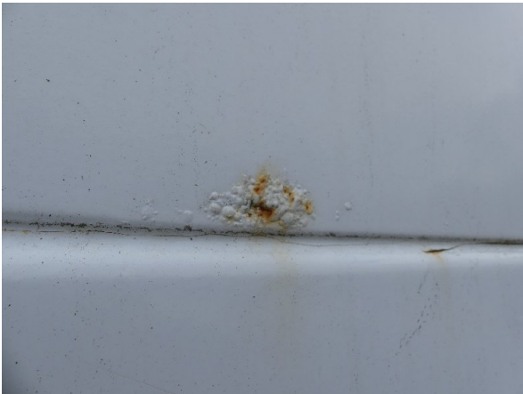
Bild 29: Seitenwand Korrosion - Smart Repair
