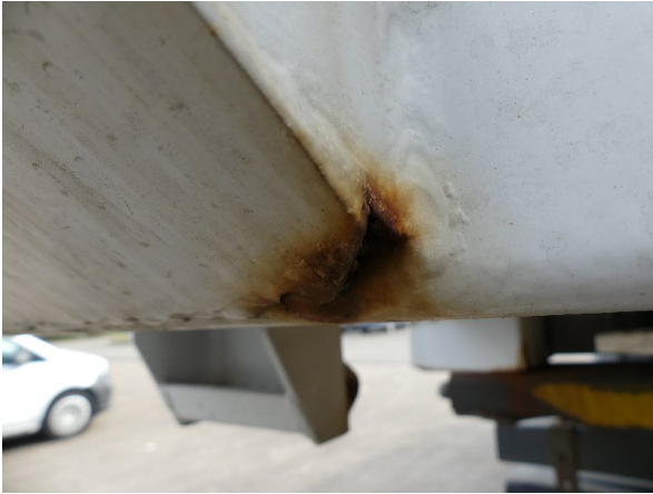
Bild 23: Eckbeplankung links Korrosion - instandsetzen und lackieren
