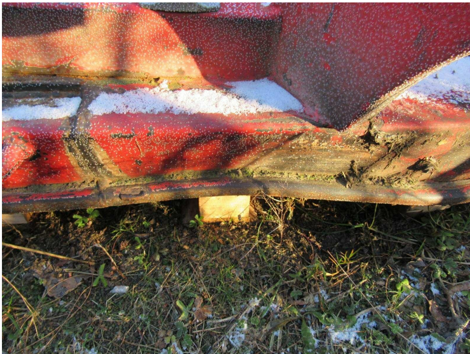
Bild 6 : Detail Rahmen verbogen
