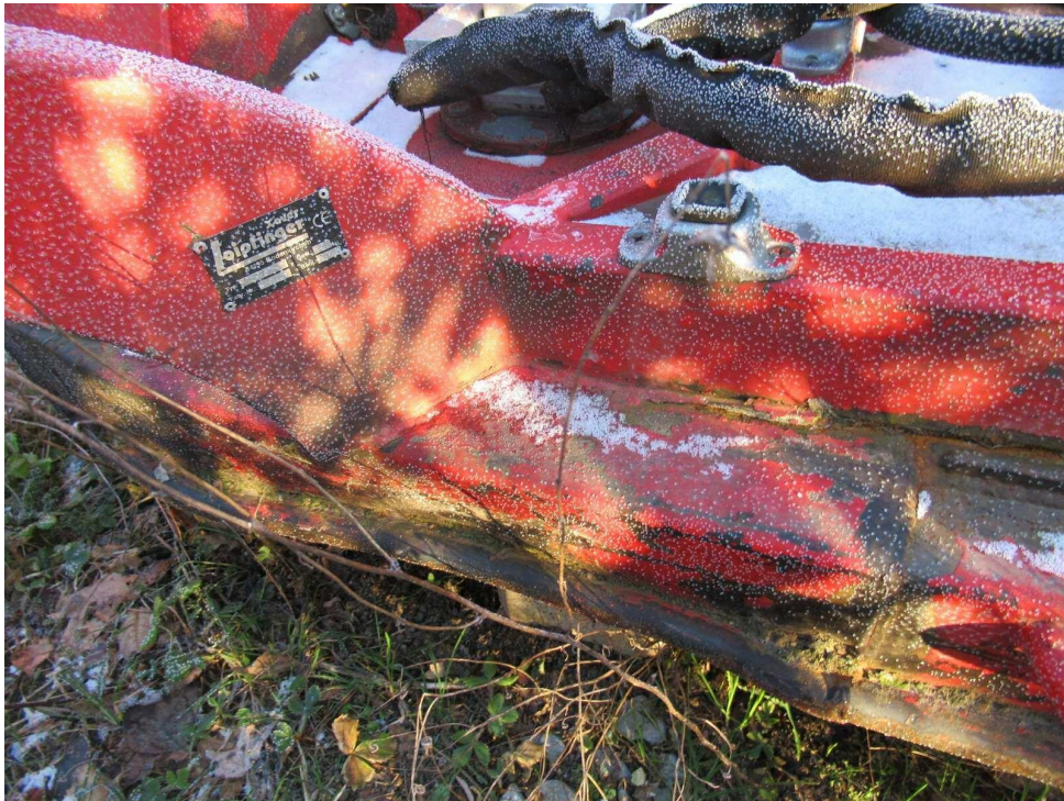
Bild 7 : Detail Rahmen verbogen
