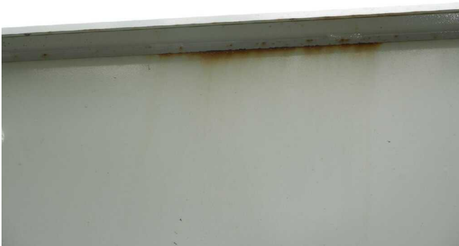
Bild 12 linke Seite Tür hinten links korrodiert
