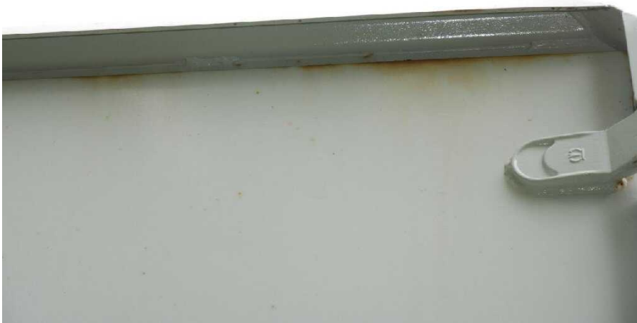
Bild 10 rechte Seite Tür hinten rechts korrodiert
